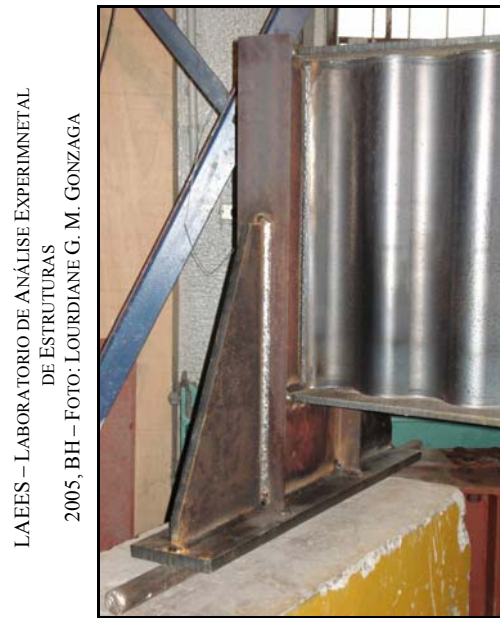
FIGURA 4.40 – Roletes metálicos entre a viga e o apoio
