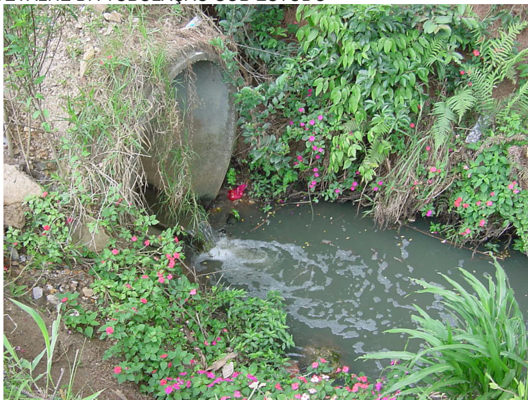
FIGURA 3.9 – DETALHE DA TUBULAÇÃO SOB ESTUDO
