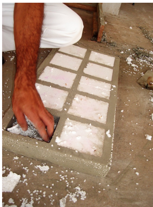
FIGURA 26 – Retirada dos cubos de isopor ao fim da cura do concreto Fonte: Acervo Próprio
