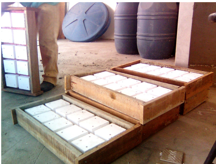
FIGURA 23 – Fôrmas de molde para a execução das placas de concreto Fonte: Acervo Próprio
