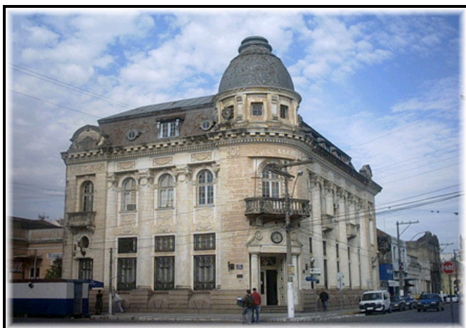
Figura 12 – Antigo prédio da SMR
