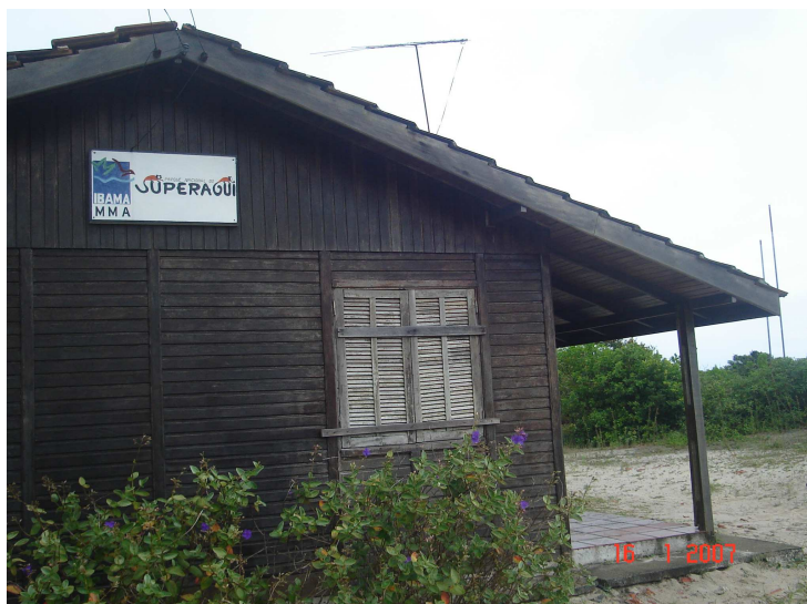
Foto n.º 1 – Sede do IBAMA na Barra do Superagui / PARNA do Superagui.
