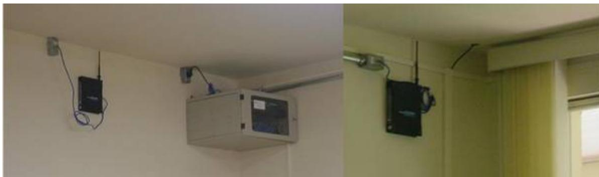
**Figura 02 – Exemplo de Pontos de Rede Sem Fio Instalados em sala de aula (um na lateral esquerda e outro na lateral direita da sala).**
