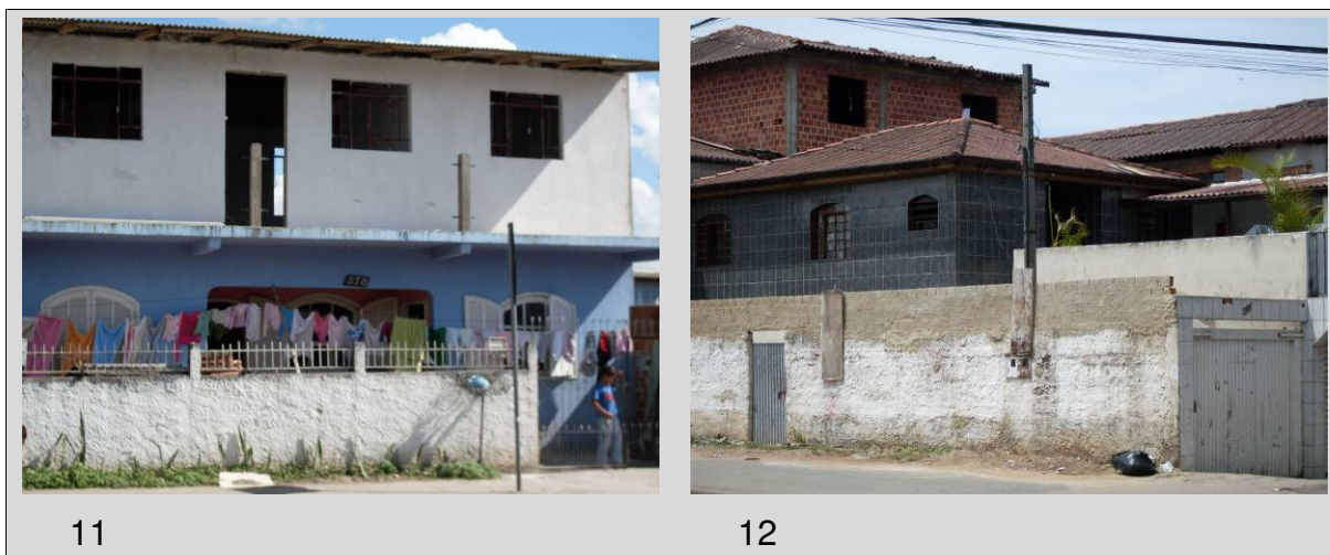
Figura 103: Vistas das edificações na Rua Guabirota no Setor Comercial na Vila das Torres – 2009
