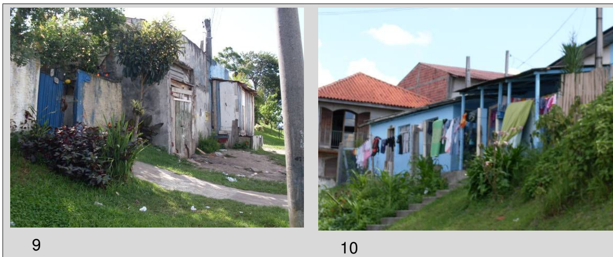
Figura 102: Vistas das edificações na Avenida Comendador Franco no Setor Comercial na Vila das Torres – 2009
