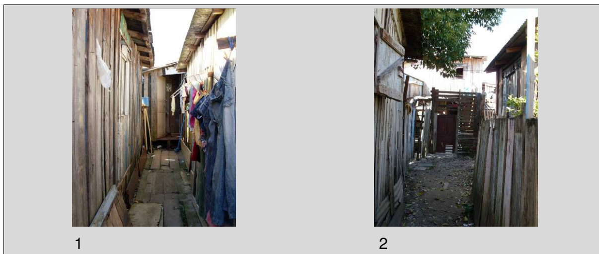
Figura 98: Vistas de moradias no Setor Irregular na Vila das Torres – 2009
