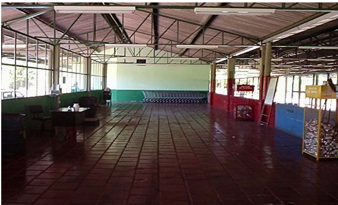
FIGURA 52 - CENTRO DE PROCESSAMENTO E TRANSFERÊNCIA DE MATERIAIS RECICLÁVEIS – ÁREA DE RECEBIMENTO DE MATERIAL
