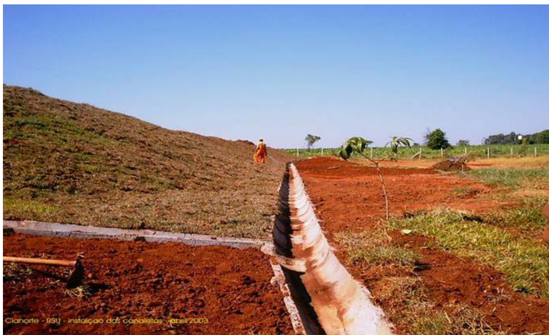
FIGURA 43 – SISTEMA COLETOR DE ÁGUAS PLUVIAIS
