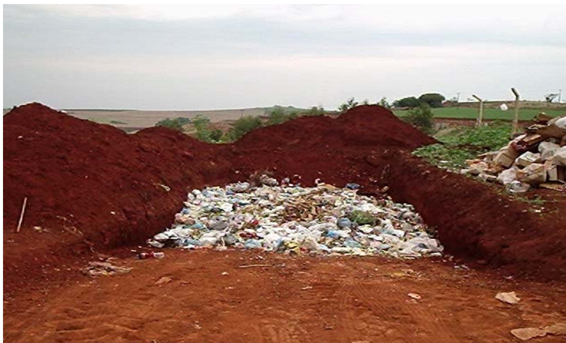
FIGURA 36 – ATERRO DOS RESÍDUOS EM SISTEMA DE VALAS
