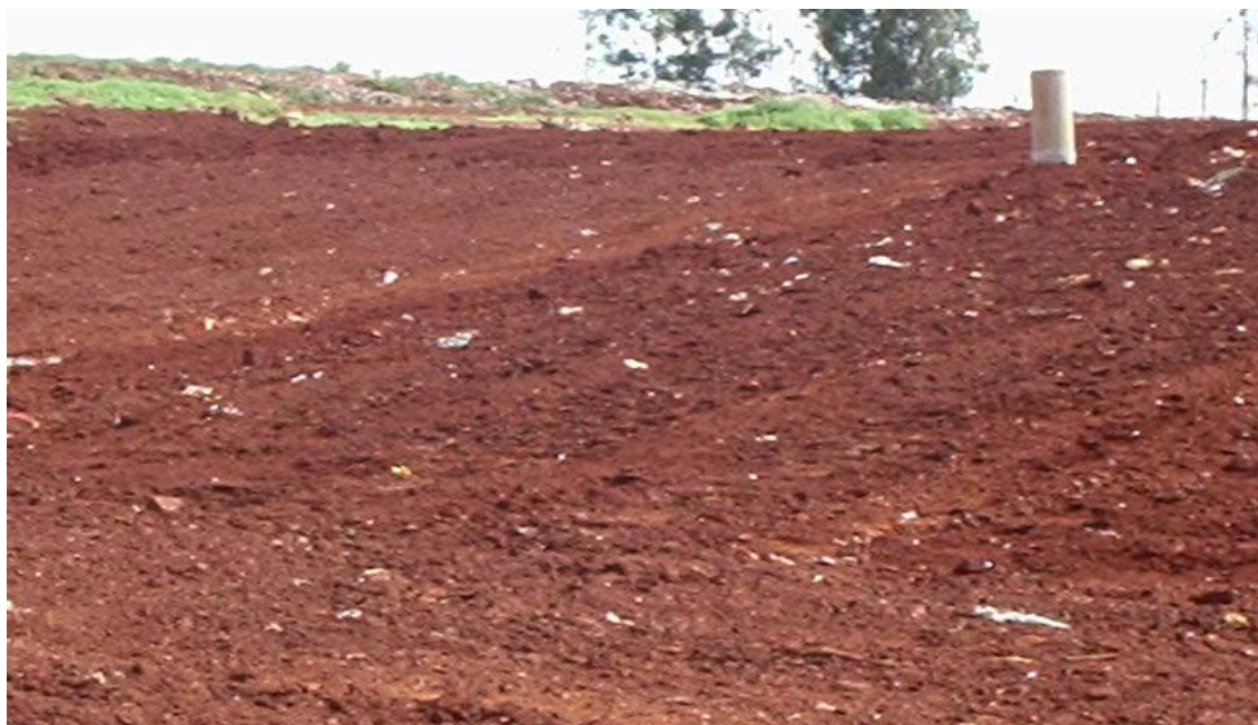
FIGURA 49 – SUPERFÍCIE DO ATERRO
