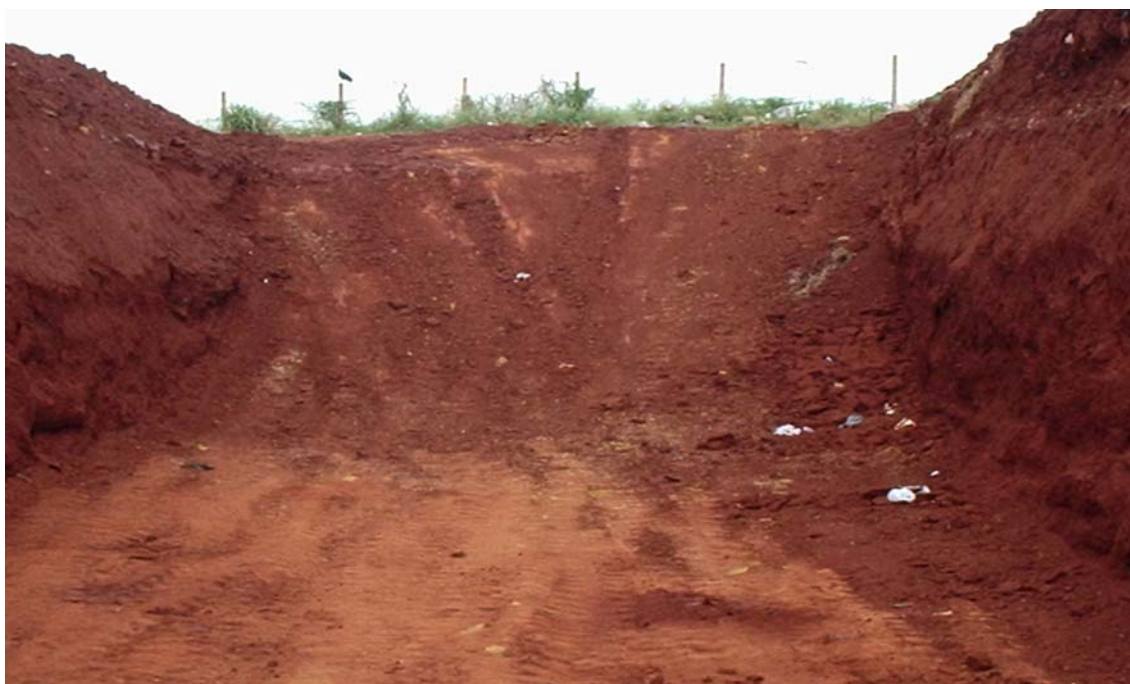
FIGURA 37 – VALA PREPARADA PARA RECEBIMENTO DOS RESÍDUOS
