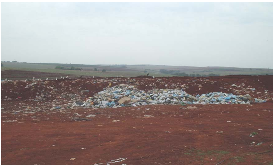
FIGURA 38 – FRENTE DE TRABALHO DO ATERRO DE ANDIRÁ
