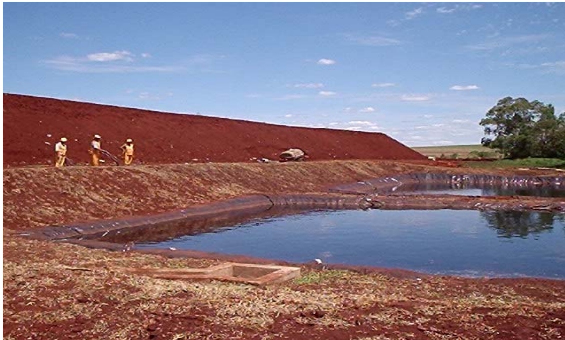
FIGURA 59 – LAGOAS DE TRATAMENTO DE CHORUME
