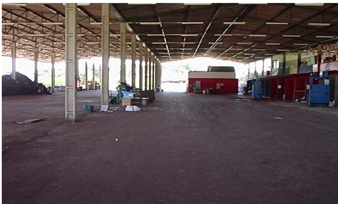
FIGURA 54 - CENTRO DE PROCESSAMENTO E TRANSFERÊNCIA DE MATERIAIS RECICLÁVEIS - ÁREA TRABALHO
