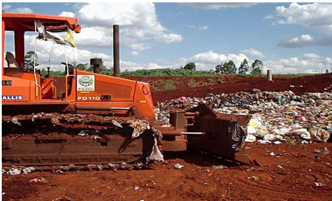
FIGURA 50 – COMPACTAÇÃO DOS RESÍDUOS SÓLIDOS
