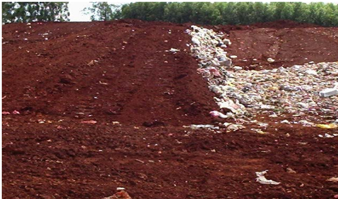
FIGURA 48 – COMPACTAÇÃO E COBERTURA DA CÉLULA AO FINAL DA JORNADA DE TRABALHO
