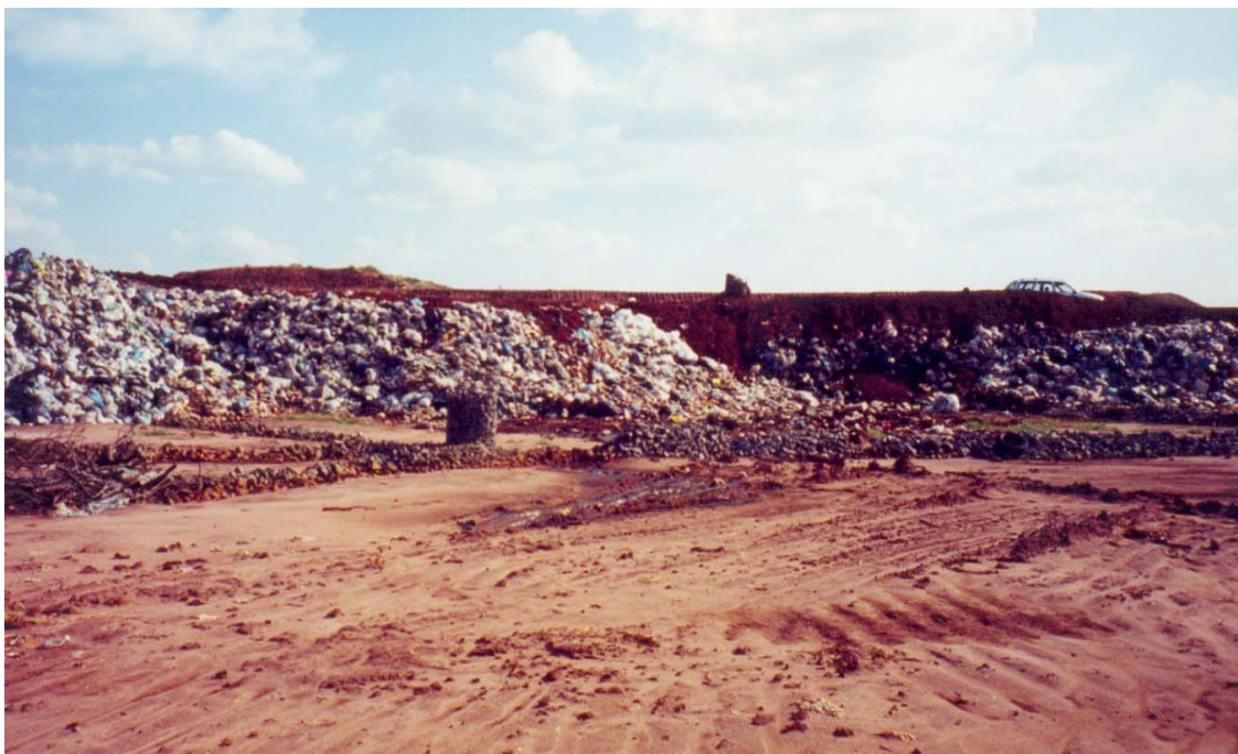
FIGURA 46 - FRENTE DE TRABALHO DO ATERRO
