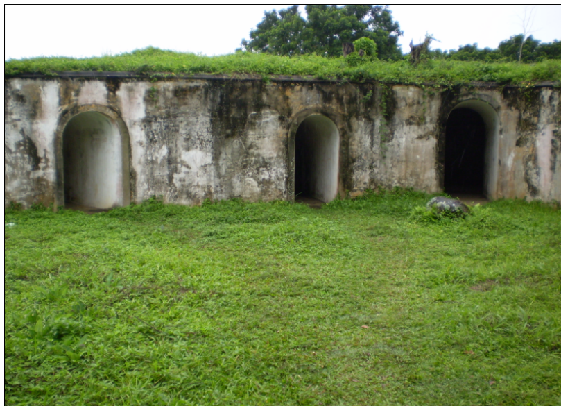
Figura 66 - Acesso ao paiol (à direita) e às duas galerias do Forte do Leme
