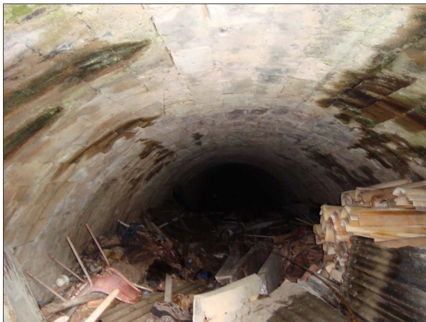
Figura 28 - Interior do “túnel”
