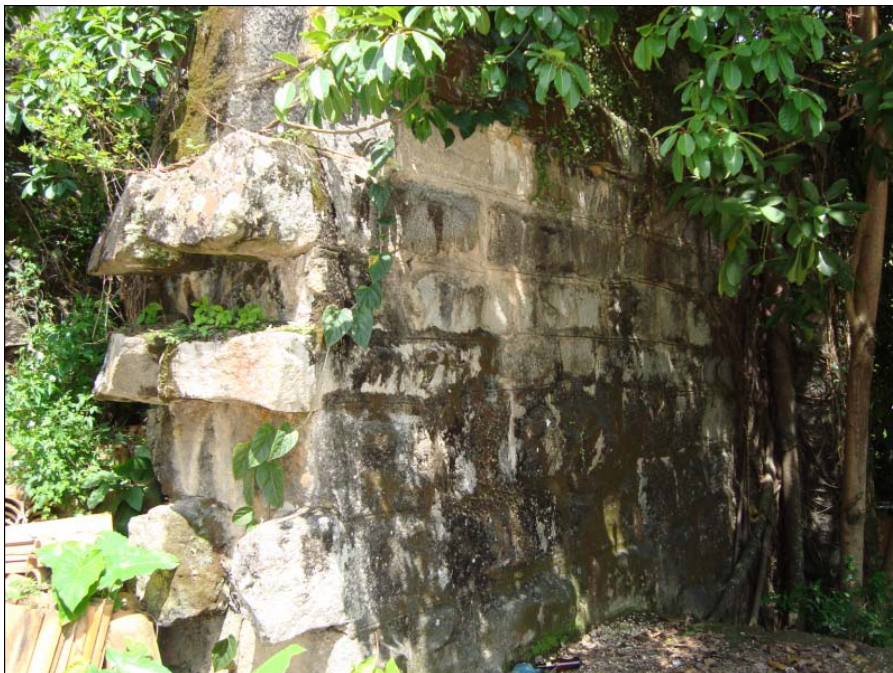
Figura 113 - Detalhe da estrutura de Monsuaba
