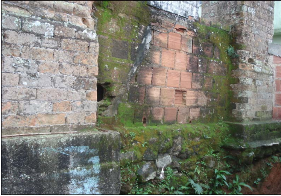
Figura 24 - Detalhe das pilastras e do muro parte de trás
