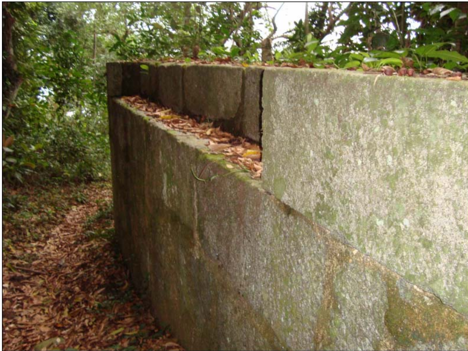
Figura 107 - Detalhe da estrutura 3.1
