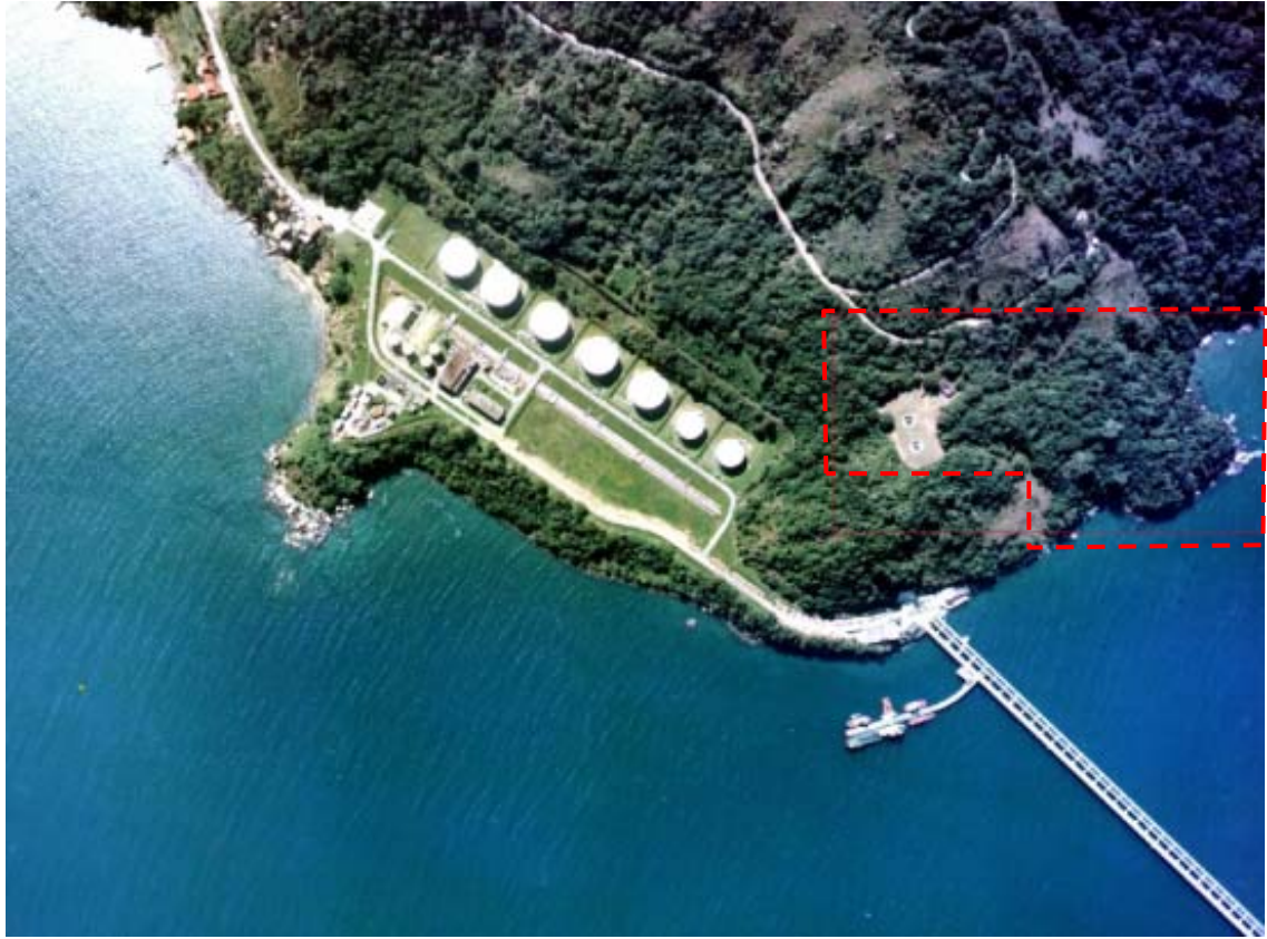
Figura 53 - Ponta Leste – Área de inspeção visual
