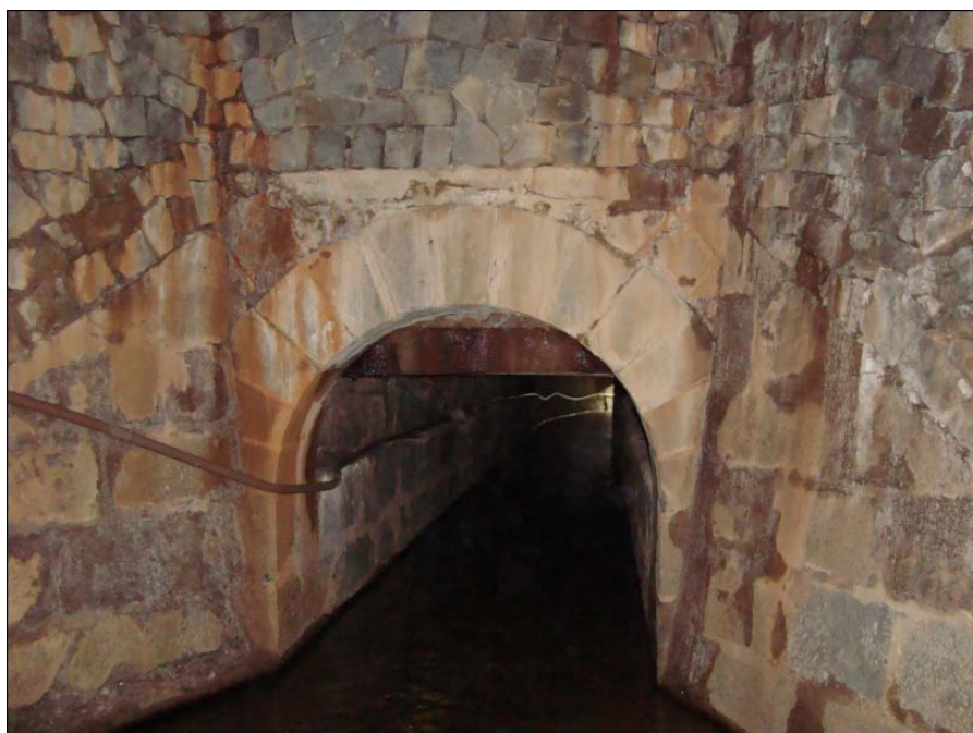
Figura 109 - Situação atual da estrutura – Praia do Coqueiro
