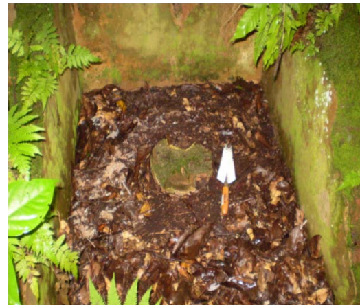
Figura 62 - Latrina do banheiro
