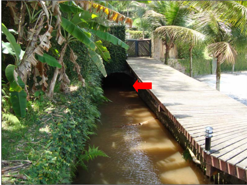
Figura 110 - Galeria de acesso à estrutura – Praia do Coqueiro
