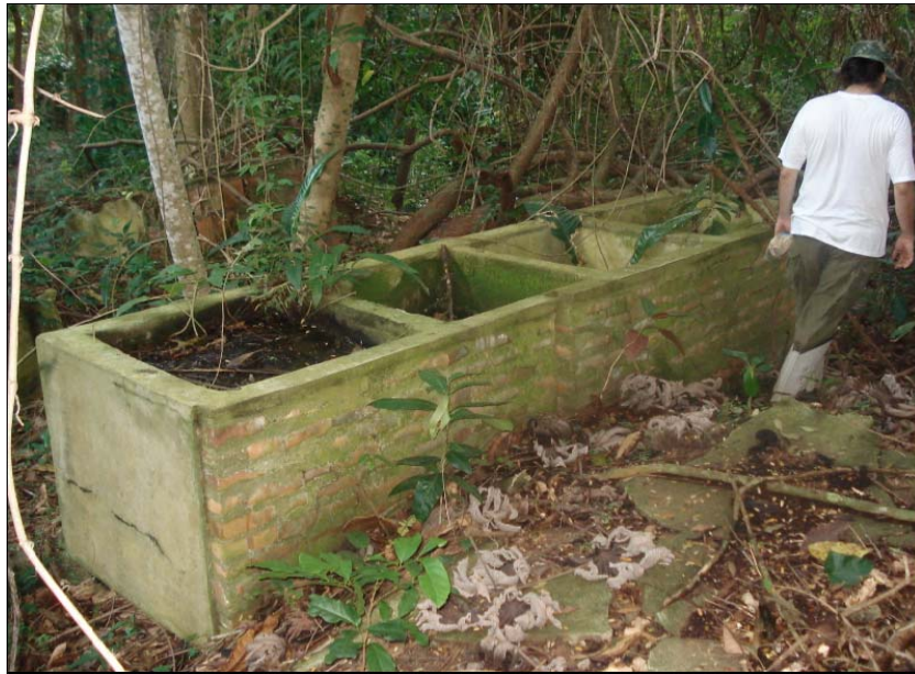
Figura 99 - Blocos de cimento acima da estrutura 4 (baias ou tanques)
