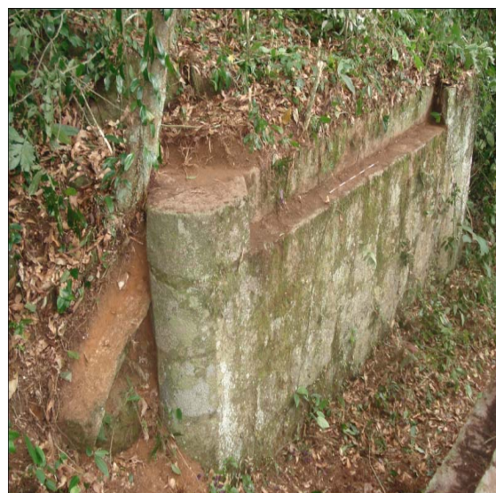
Figura 105 - Estrutura 3.2 – limpeza do lado externo
