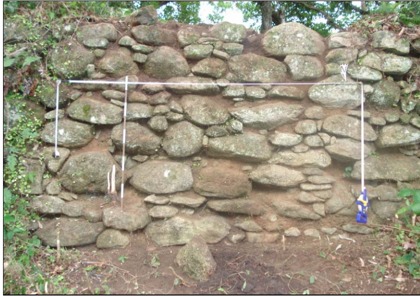
Figura 94 - Detalhe da face sondada na estrutura 2
