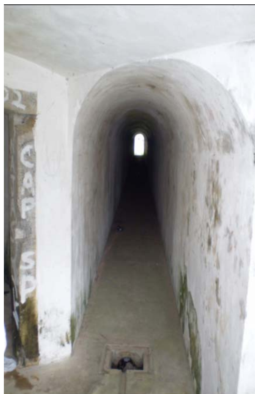
Figura 68 - Galeria subterrânea do Forte do Leme
