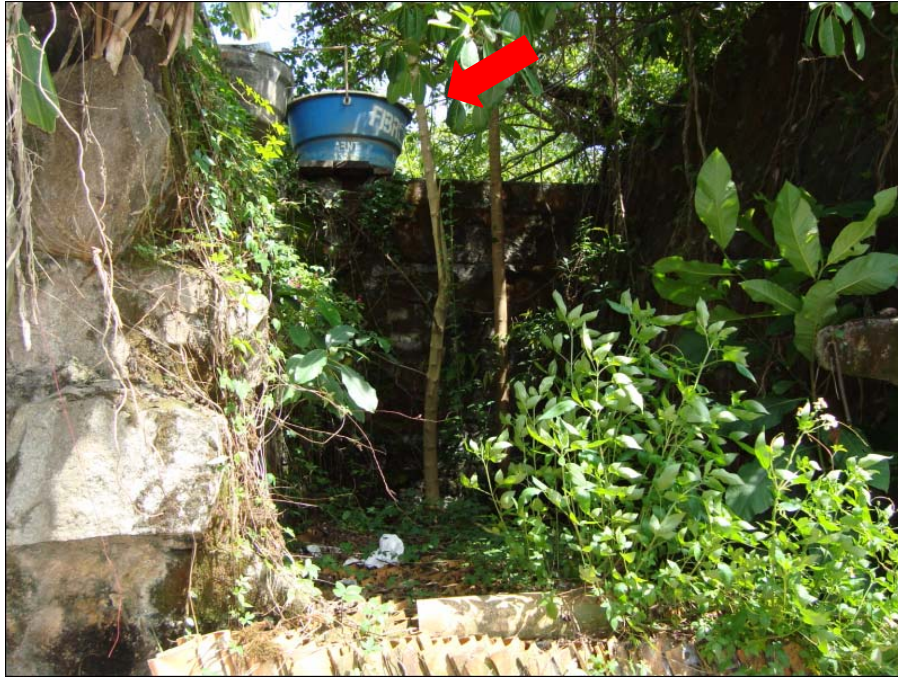
Figura 114 - Parede da estrutura de Monsuaba que serve de apoio para uma casa, construída logo atrás
