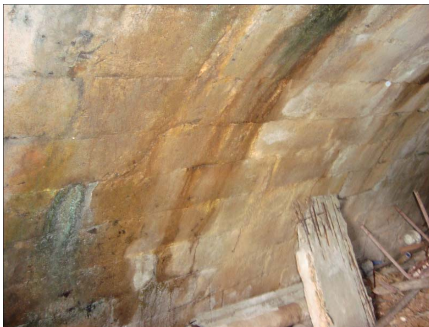
Figura 29 - Detalhe dos tijolos no interior do “túnel”
