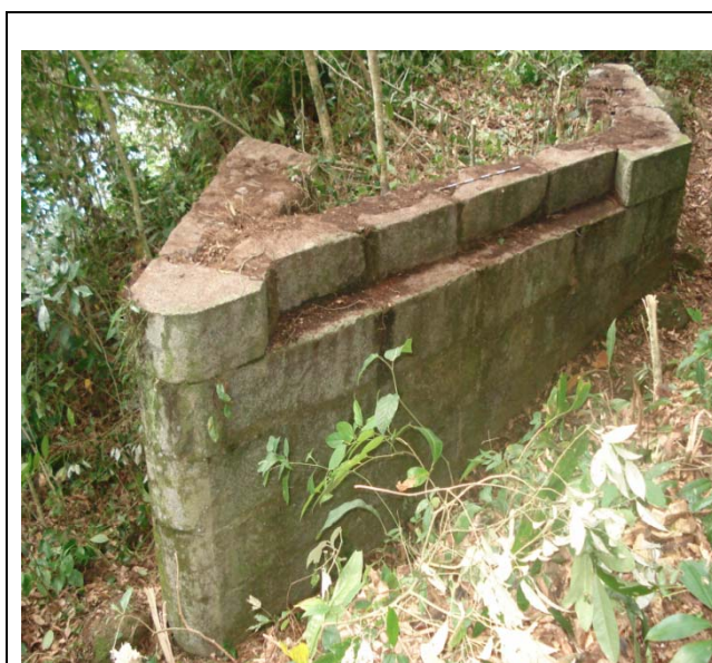
Figura 104 - Estrutura 3.1 – limpeza do lado externo
