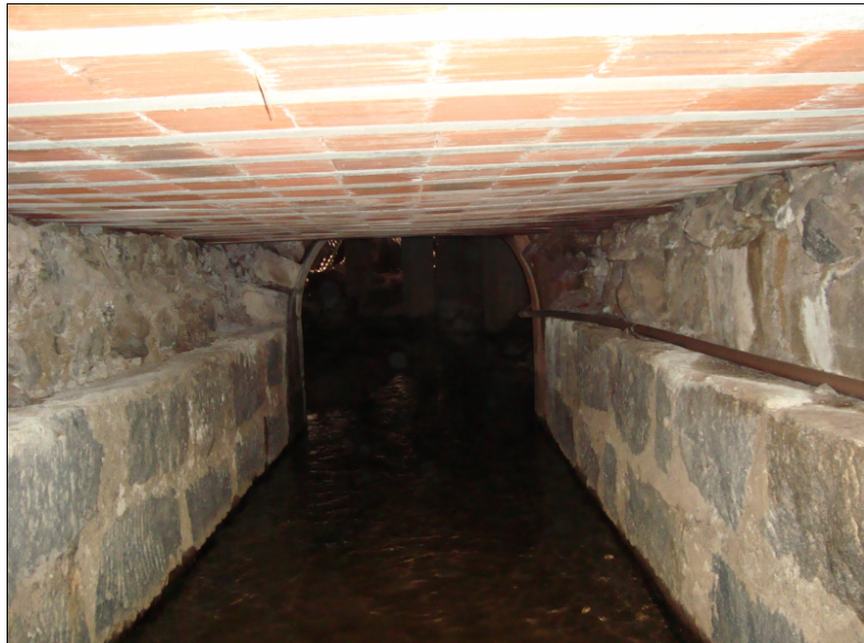
Figura 111 - Detalhe da parte interna da galeria
