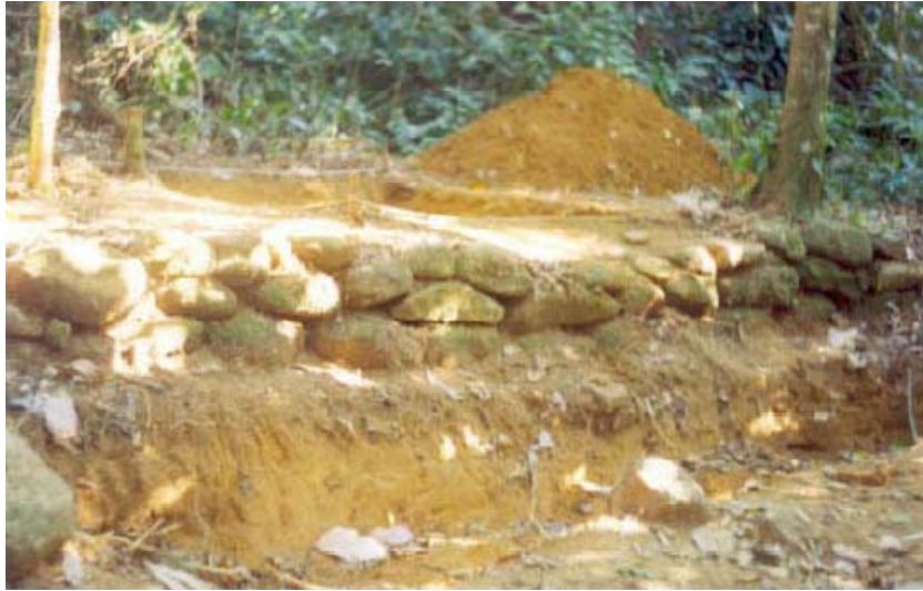
Figura 12 - Alinhamento de pedra
