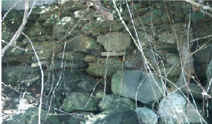
Figura 8 - Muro de pedra próximo à Marina
