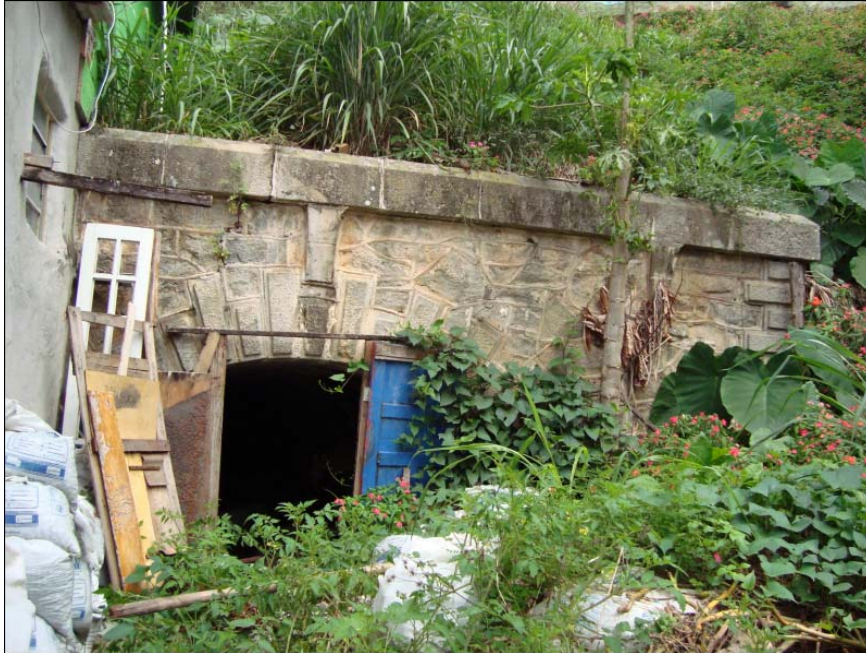
Figura 27 - Frente do "túnel"
