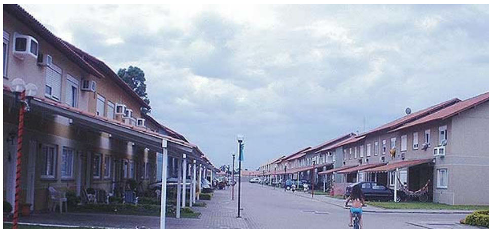
Figura 6: foto representativa da tipologia dos empreendimentos da Construtora C.
