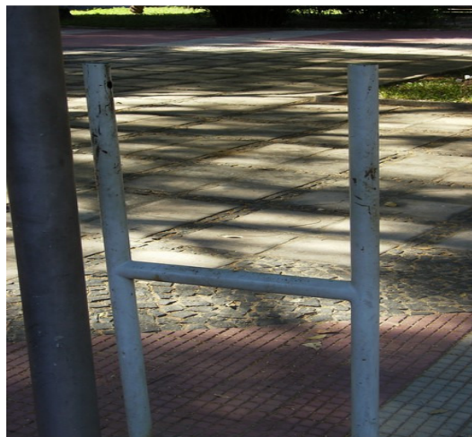
Figura 5.14: Lixeira quebrada, sinal de vandalismo na Praça Landri Sales.
