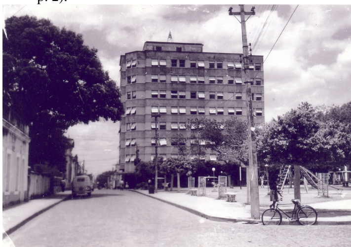
Figura 4.1: Praça João Luis Ferreira na década de 1960 Fonte: Acervo do Espaço cultural São Francisco
