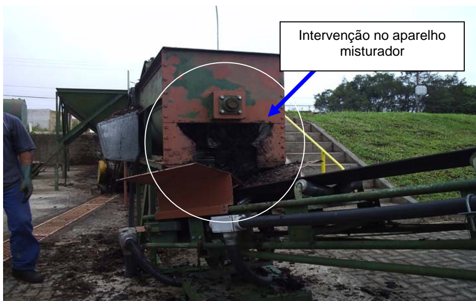
FIGURA 4.3 – INTERVENÇÃO EMERGENCIAL - ABERTURA PARA SAÍDA DO MATERIAL NO APARELHO MISTURADOR
