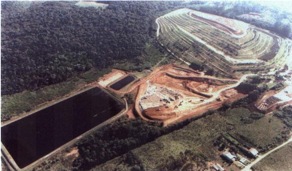
FIGURA 2.2 – VISTA GERAL – ATERRO DA CAXIMBA - CURITIBA
