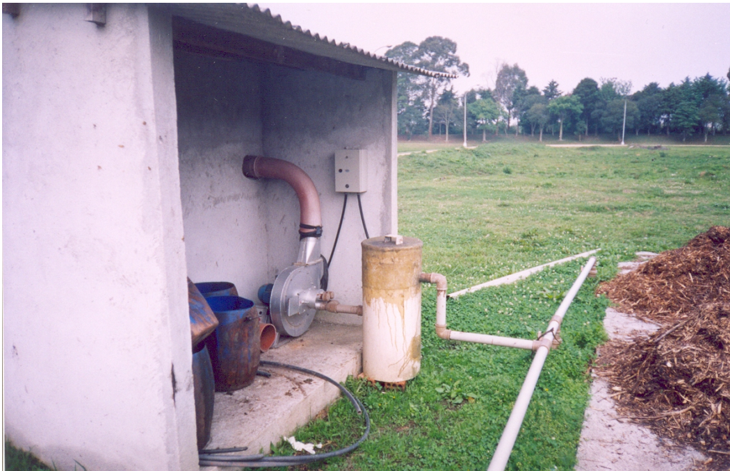
FIGURA 2.4 – DETALHE DE AERAÇÃO – SANEPAR
