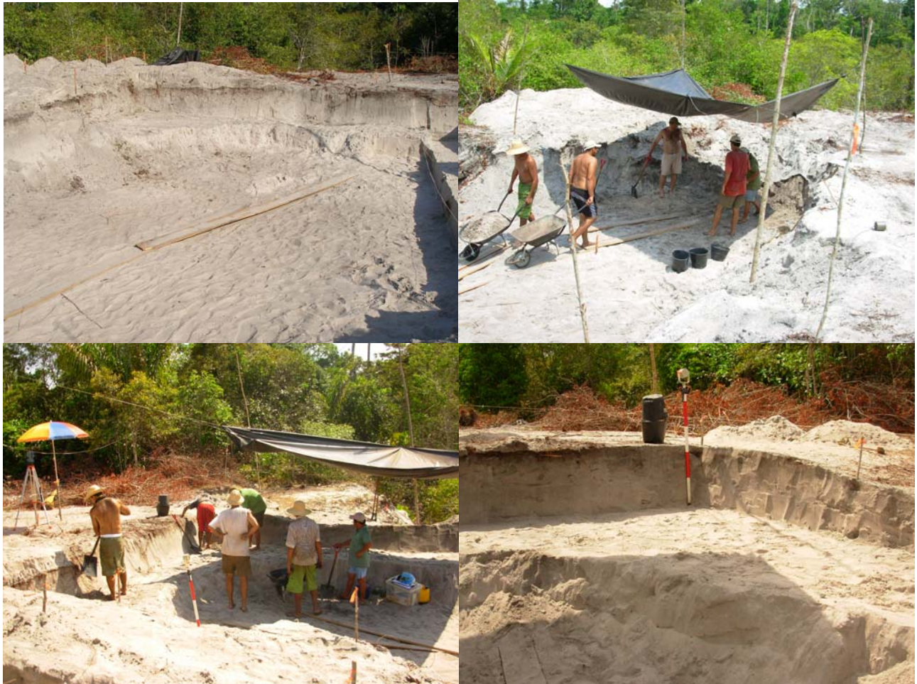
Fotos 83 a 86. Preparação da área onde foi escavada a trincheira (Fotos C. Pinto)
