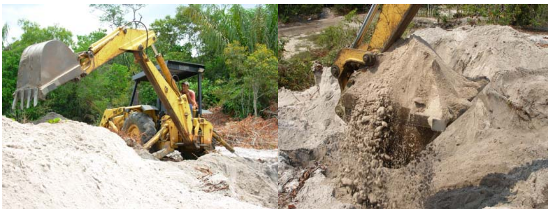
Fotos 61 e 62. A retro-escavadeira em ação (Foto C. Pinto).
