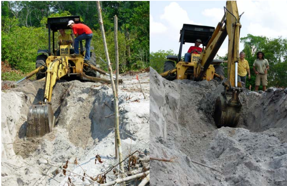
Fotos 63 e 64. A retro-escavadeira iniciando o trabalho (Fotos C. Pinto).
