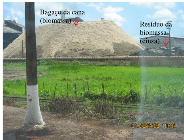
Figura 1.1. Depósito permanente de bagaço da cana-de-açúcar para utilização como biomassa nas caldeiras da Usina Estivas e depósito de resíduo da biomassa (cinza).
