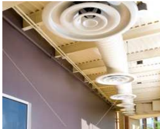
Figura 1.1: Grelhas de saída de um sistema de ventilação e ar condicionado.
