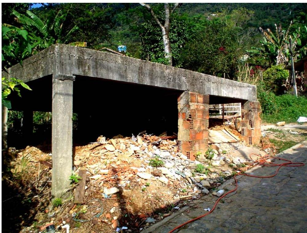
**FOTO 42: CASA SENDO CONSTRUÍDA EM DECLIVIDADE SUPERIOR A 14°, LOCALIZADA NA RUA DA ASSEMBLÉIA, DESTAQUE PARA A INCLINAÇÃO DOS ALICERCES DA EDIFICAÇÃO (Foto da Autora, 2005).**
