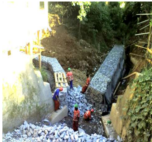
c) Diques de contenção, favorecendo a infiltração e drenagem.
