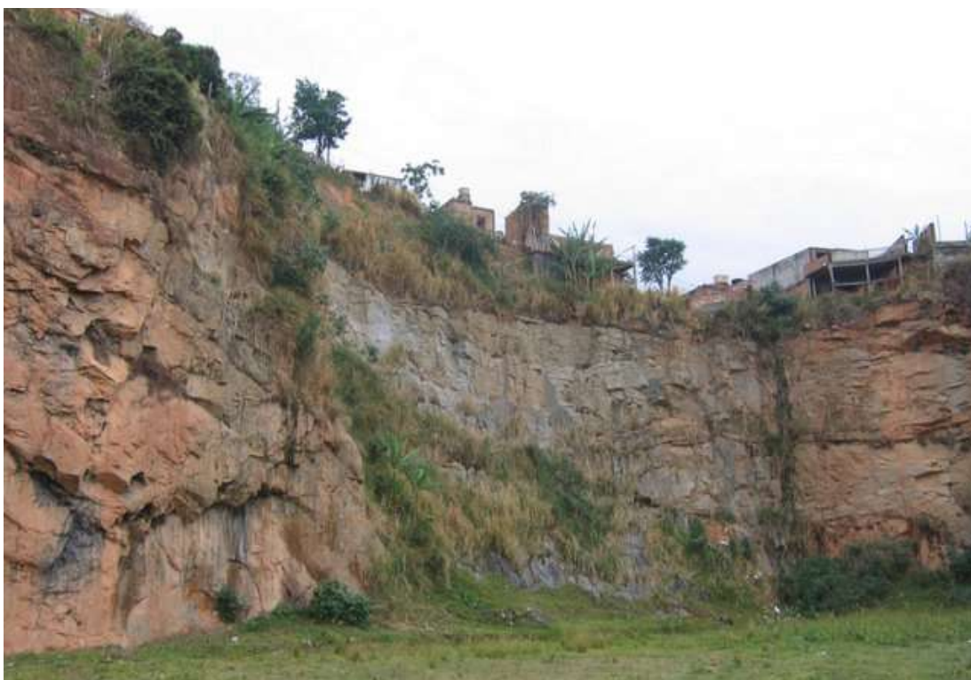
Figura 5.7 – Pedreira no bairro Engenho Nogueira, em gnaisse muito fraturado com possibilidade de queda de rocha e detritos (quadrícula H4 da Figura 5.3).
