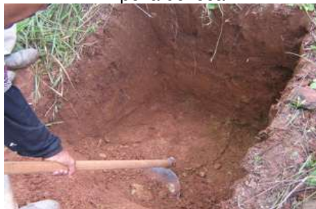
Preparação para cravação.
