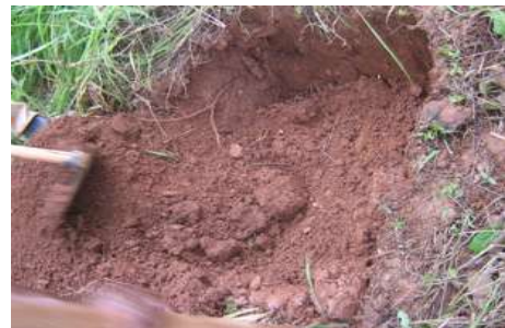
Abertura de vala.
