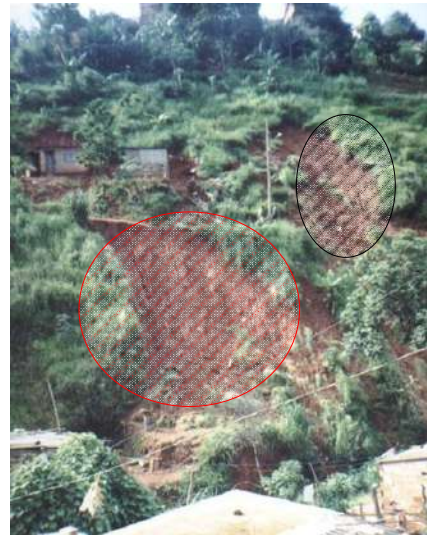
Situação após a ruptura (Janeiro de 2003).
