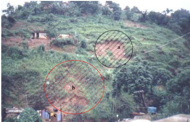
Situação antes da ruptura (Dezembro de 2002). Demarcado pelas letras “a”, “b” e “c”, as posições de coleta das amostras de Parizzi (2004): Tálus amarelado, Tálus avermelhado e Aterro, respectivamente.
