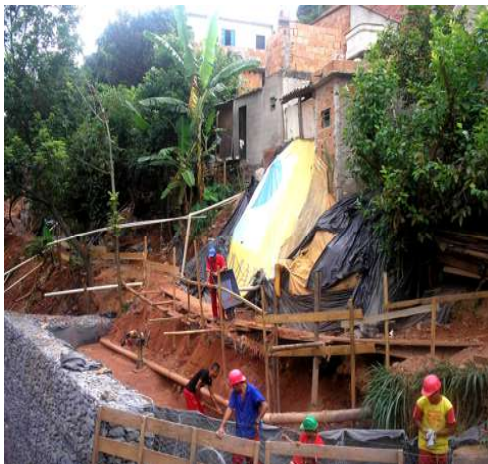
c) Diques de contenção, favorecendo a infiltração e drenagem.
