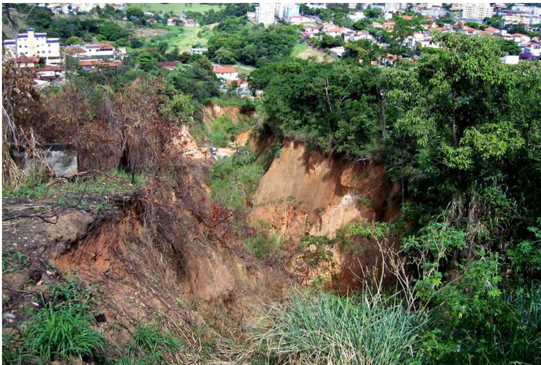
Figura 5.5 – Possibilidade de escorregamento das paredes de voçorocas, presentes no Complexo Belo Horizonte (quadrícula K8 da Figura 5.3).
