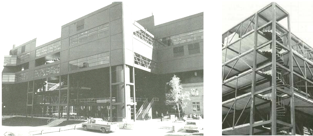
FIGURA 1.1.2 Construções com uso de pilares mistos, Fonte CIDECT- Bergmann (1995).
