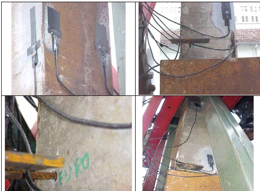
FIGURA 5.15.5c MSA-“Strain-gages”-concreto e perfil. Suporte para DT.
