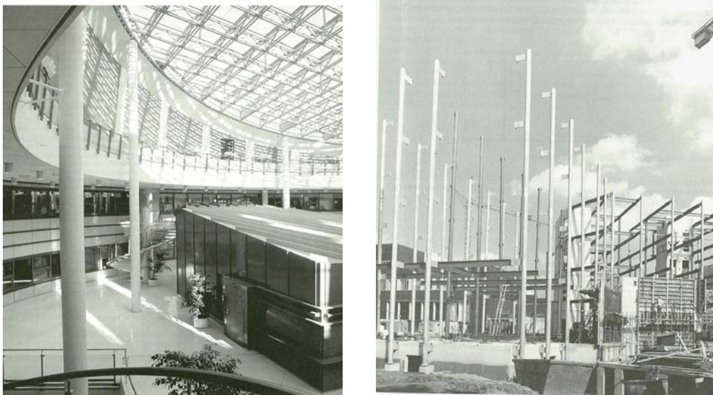
FIGURA 1.1.1 Estruturas em pilares mistos. Fonte CIDECT- Bergmann(1995).
