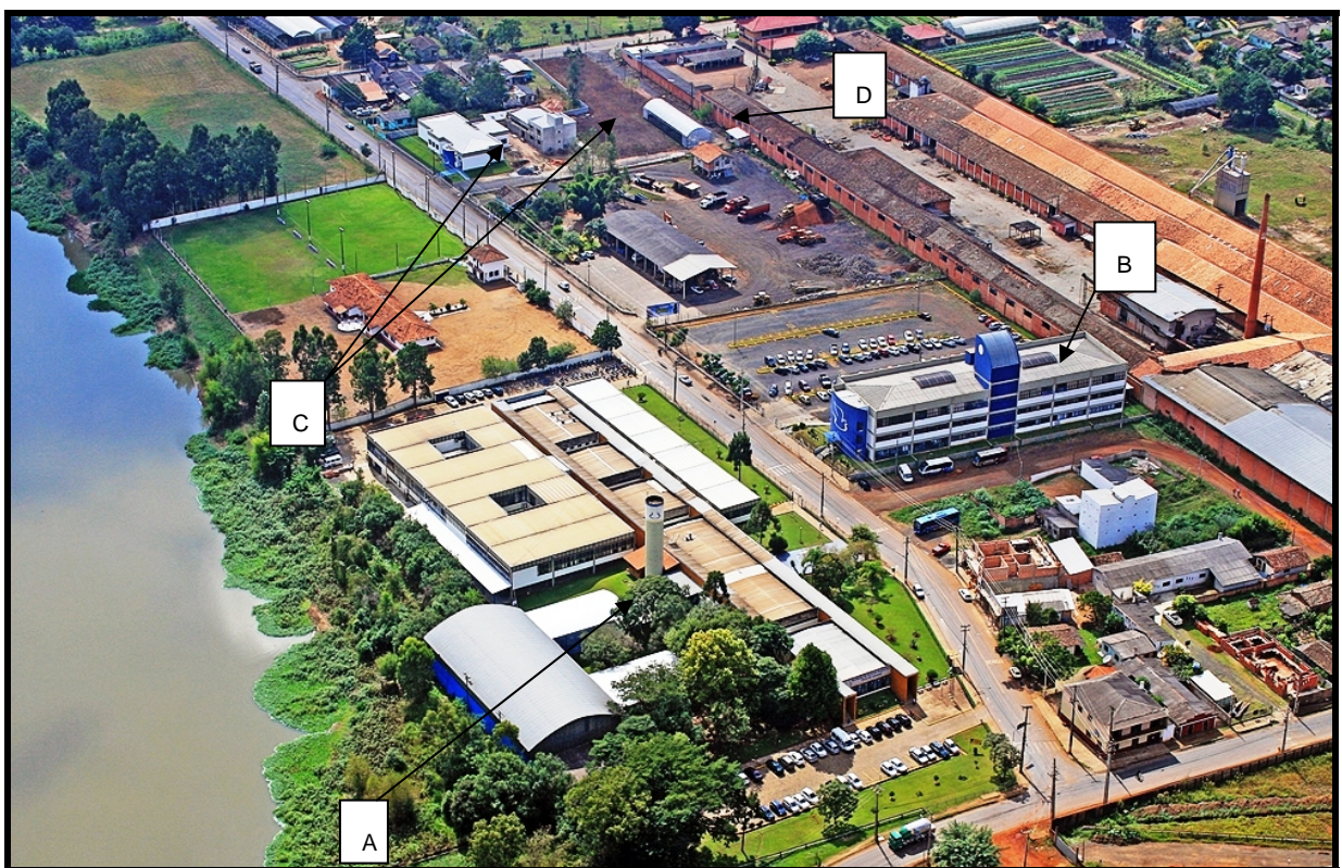
Figura 3 – Vista aérea da UNIGUAÇU – Rua Padre Saporiti nº 717, Bairro Rio D'Areia, União da Vitória/PR
