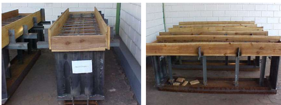
FIGURA 3.5 Escoramento dos protótipos na fabricação
