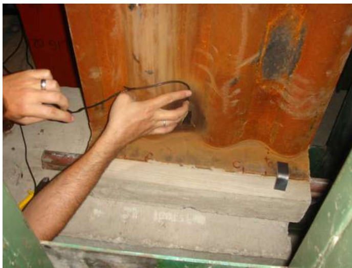
FIGURA 3.15 Instalação dos extensômetros elétricos
