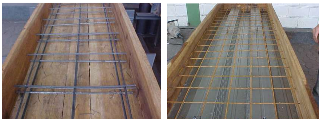
FIGURA 3.6 Formas de madeira usadas na fabricação das lajes maciça e mista
