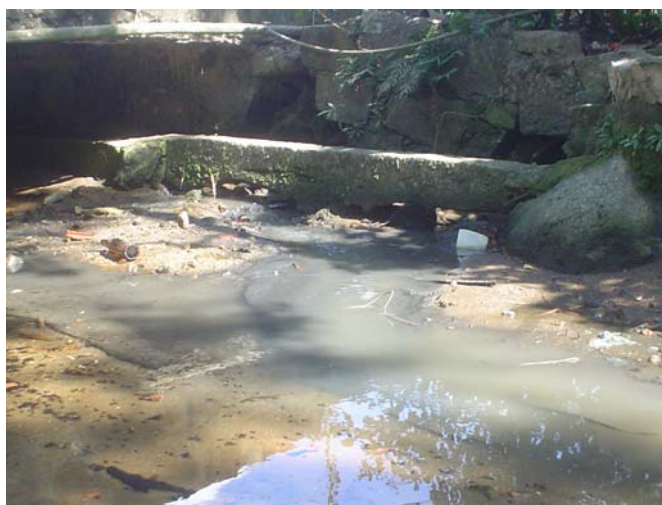
Foto 8: Vazamento de esgoto no Córrego do Bicão Fonte: Ana Lúcia de Oliveira, 2005
