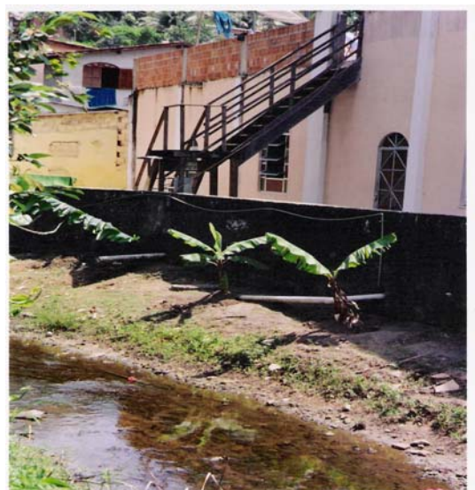
2: Córrego Dona Gabi em seu baixo curso (cruzando a rua Getúlio Vargas) – detalhe para saídas de esgoto e plantio de bananeiras. Fonte: A autora. 2005.
