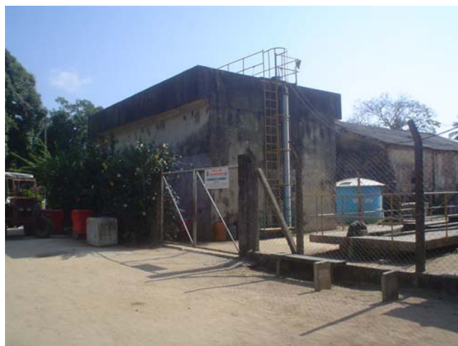
20: Estação de tratamento de esgoto- Vila de Abraão.
