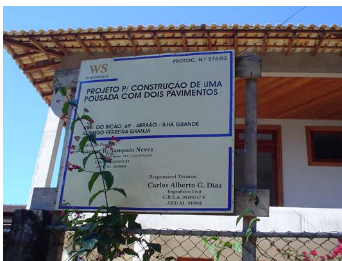
Foto 7: Placa indicando projeto para construção de uma pousada com dois pavimentos- Rua das Flores.
