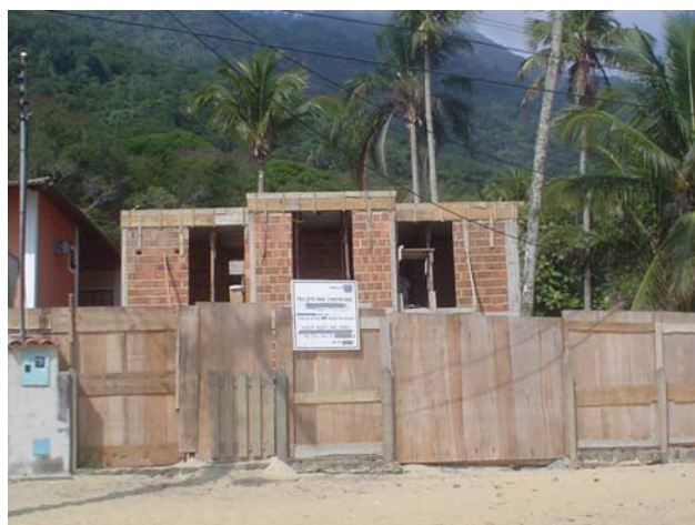
1B: Construção de pousada no baixo curso do Córrego Pedra d'Água, na faixa de praia. Fonte: Ana Lúcia de Oliveira, 2005.
