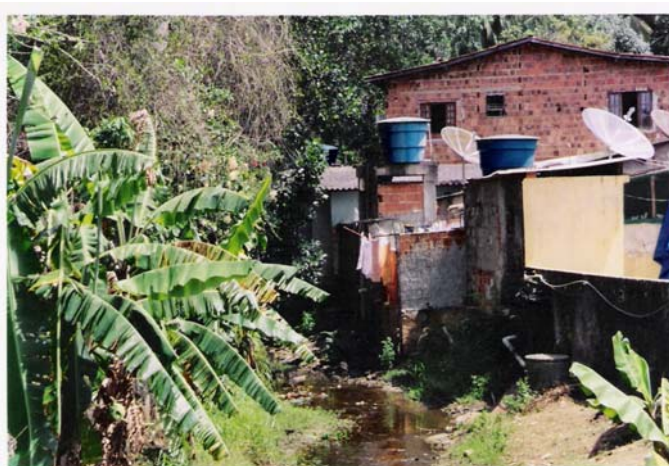
3: Córrego Dona Gabi em seu baixo curso – detalhe da ocupação que invade a área de proteção florestada / saídas de esgoto/ presença de lixo.
