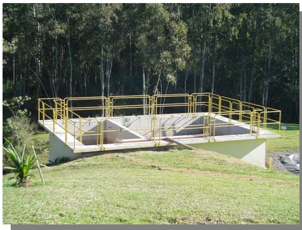
Figura 4: Tanque de homogeneização.
