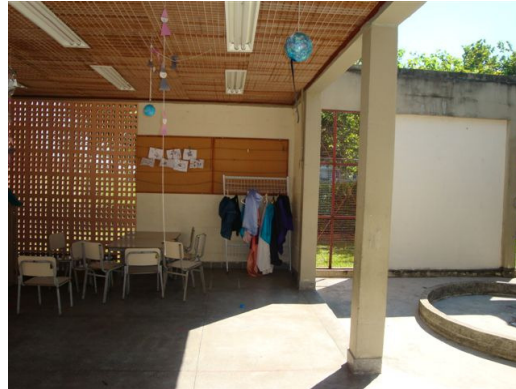
Figura XI- Continuação do pátio interno
