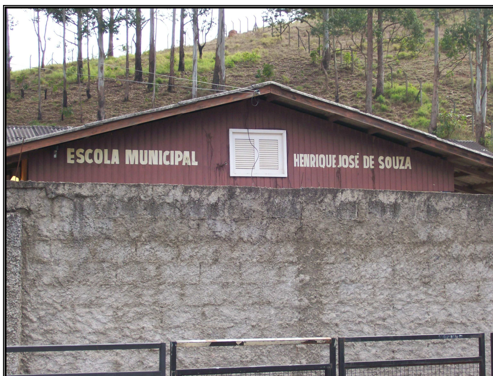
Figura 1: Fachada da escola, com destaque para o muro
