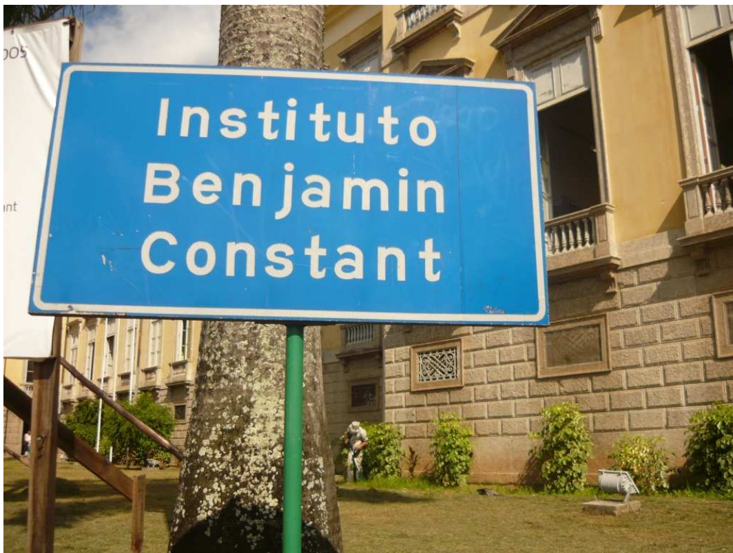
Figura 14: O IBC depois da reforma em amarelo.
