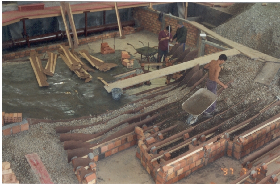
FIGURA 7.2 – CONSTRUÇÃO DO MODELO FÍSICO – MOLDAGEM DA SUPERFÍCIE DE CIMENTO
