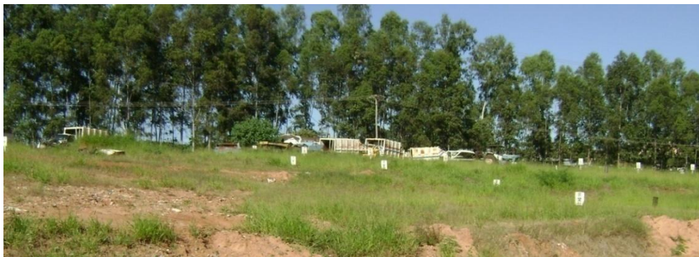
Figura 55 – Localização das valas sépticas (para disposição dos RSS) no aterro sanitário de Bauru.
