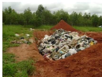
Figura 96 – Vala aberta preparada para ser coberta.
