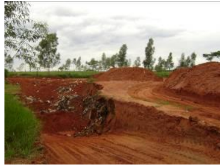
Figura 32 – Detalhe da vala onde estão sendo depositados os resíduos.
