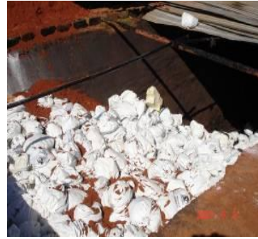
Figura 56 – Construção de vala séptica e disposição dos RSS em vala previamente preparada no aterro sanitário de Bauru. Fonte: LOPES, 2007.
