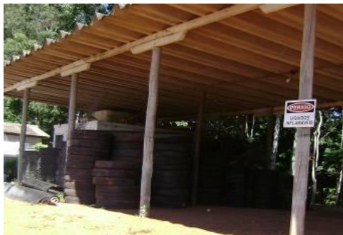
Figura 52 - Barracão do aterro sanitário onde são armazenados os pneus coletados pela EMDURB.
