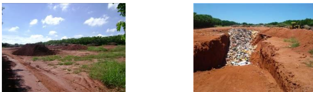
Figura 174 – Aterro em valas de Reginópolis. Vista geral do local e detalhes da vala, mostrando presença de animais.
