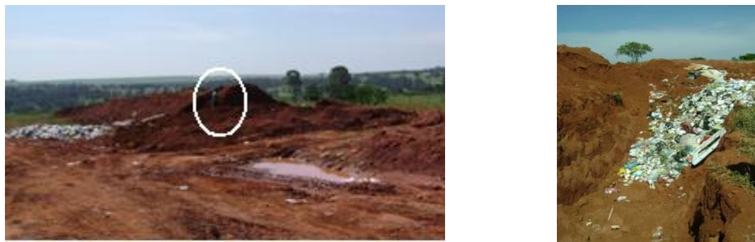
Figura 160 – Vista geral do aterro e detalhe da vala de trabalho, mostrando a presença de uma família de catadores coletando materiais no local.
