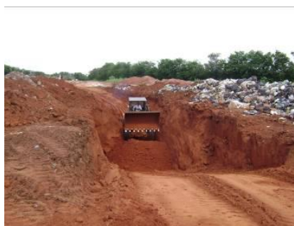
Figura 112 – Resíduos aguardando para serem dispostos na vala escavada.
