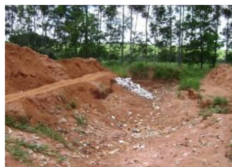
Figura 78 – Vala aberta, onde estão sendo depositados os resíduos.
