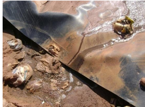
Figura 08 – Detalhe do chorume caindo diretamente no solo de base.
