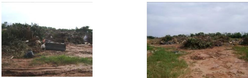
Figura 110 – RCC “sujo”, misturado aos resíduos de poda e capina no aterro.
