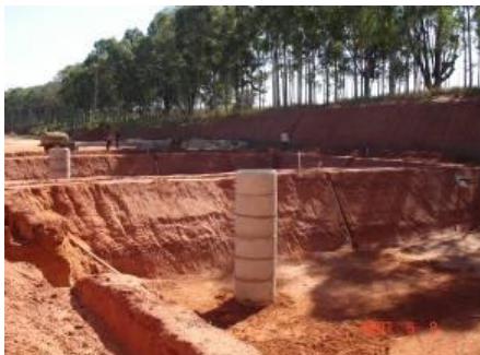
Figura 57 – Construção das duas lagoas de chorume do aterro sanitário de Bauru. Fonte: LOPES, 2007.
