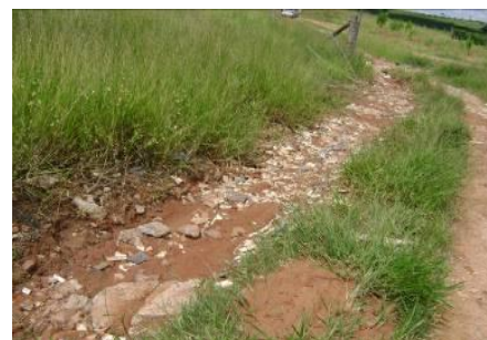
Figura 101 – Aplicação dos RCC na correção de estradas municipais.
