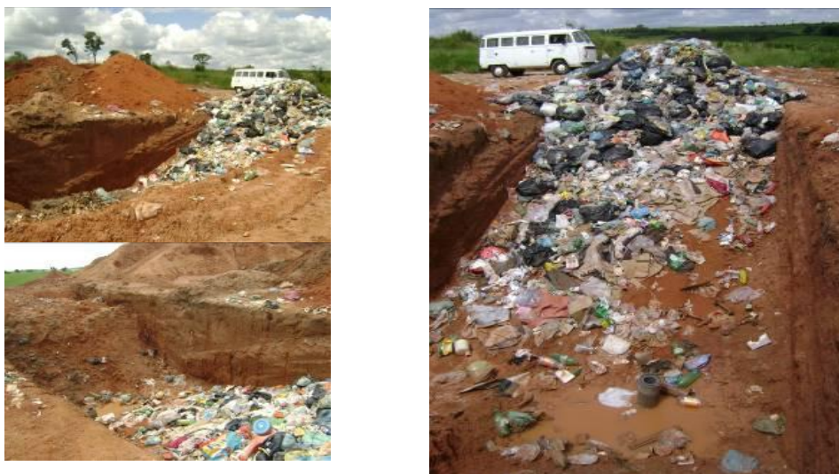
Figura 103 – Resíduos sendo depositados em vala do aterro de Gália.
