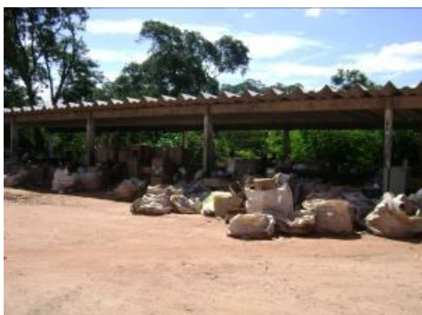
Figura 39 - Galpão de recebimento de materiais recicláveis ainda aguardando triagem.
