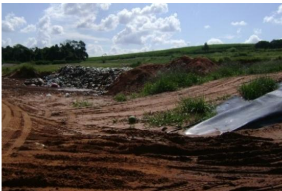
Figura 09 – Disposição dos RSD ao lado da vala, aguardando para serem aterrados.
