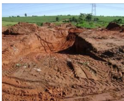
Figura 171 – Visão geral do aterro, com vala sendo aberta para disposição dos resíduos.
