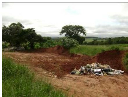
Figura 147 – Visão da área do aterro com detalhe da vala em uso.
