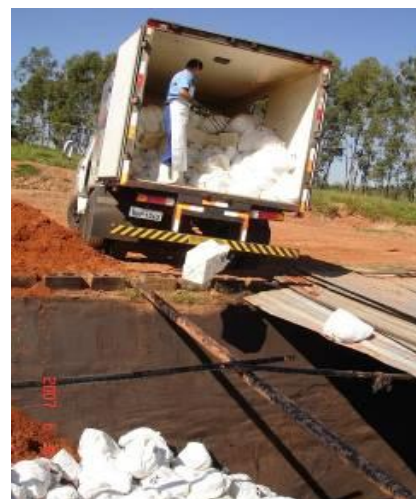
Figura 51 - Disposição dos RSS em valas sépticas no aterro sanitário do município de Bauru.
