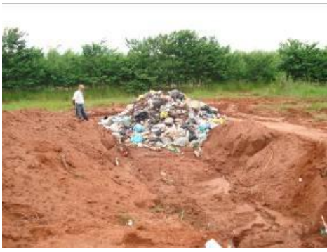
Figura 27 – Visão geral do aterro e detalhe dos resíduos sendo depositados na vala.
