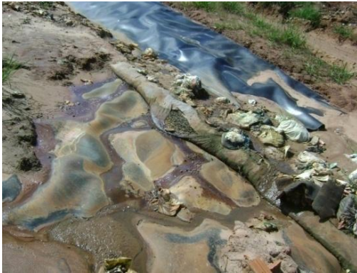
Figura 07 – Extremidade da manta de impermeabilização.
