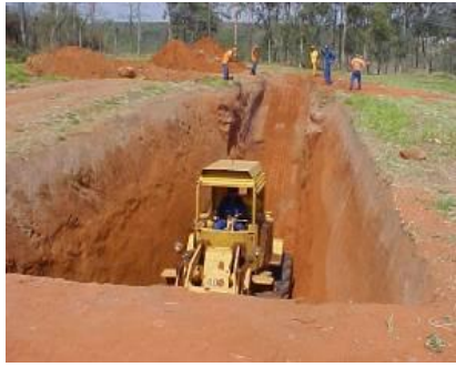
Figura 56 – Construção de vala séptica e disposição dos RSS em vala previamente preparada no aterro sanitário de Bauru. Fonte: LOPES, 2007.
