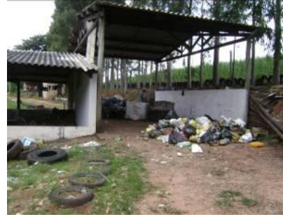
Figura 73 – Barracão onde os recicláveis são separados dos RSD e triados para comercialização.
