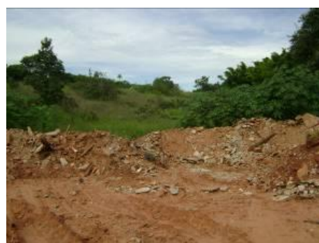
Figura 133 – RCC depositado em terreno para ser usado na correção de estradas municipais.
