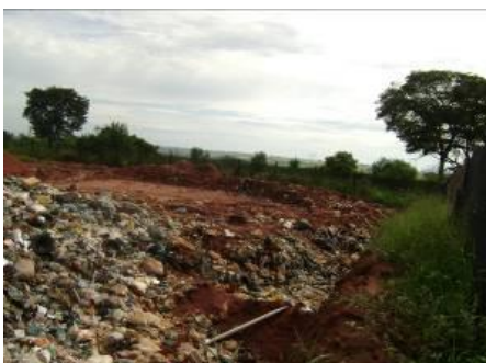
Figura 134 – Valas de trabalho no aterro de Lucianópolis aguardando cobertura.
