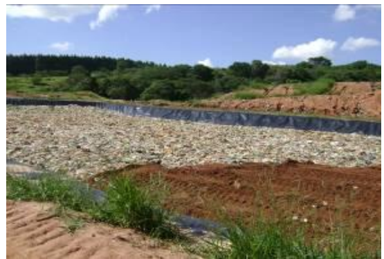
Figura 10 – Visão da única vala do aterro sendo coberta com terra.
