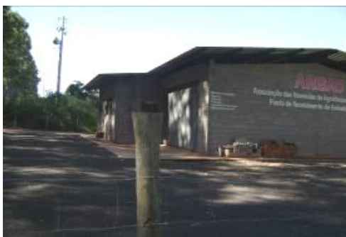
Figura 59 – Barracão onde são recebidas e armazenadas embalagens de agrotóxicos vazias.
