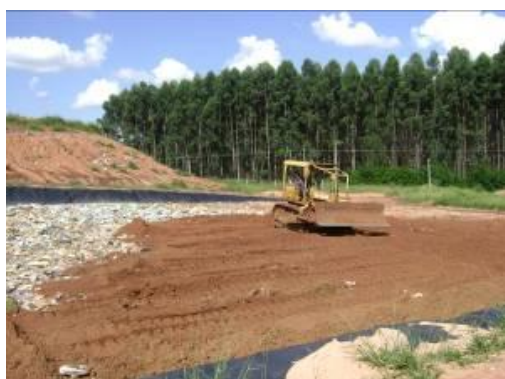
Figura 05 – Trator cobrindo vala do aterro.
