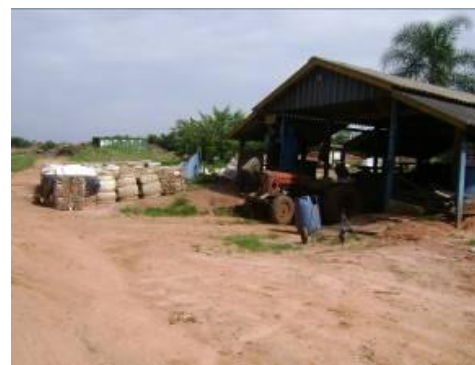
Figura 106 – Barracão de triagem dos materiais recicláveis no aterro.
