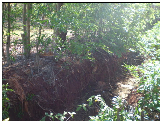
Figura 23 - Detalhe da voçoroca da Rua 22 de Abril (Acervo Pessoal).
