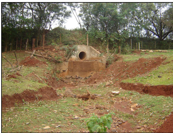
Figura 15 - Início da feição erosiva nas proximidades do Trevo que liga Marechal Cândido Rondon a Guaíra. Acervo Pessoal.
