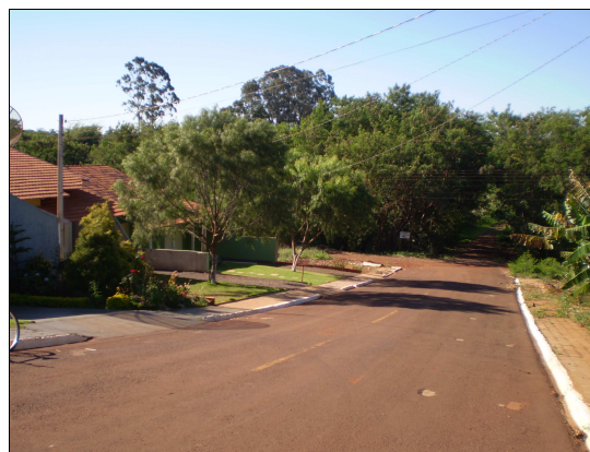
Figura 18 - Detalhe das casas construídas a menos de 50 m do Córrego Guavirá. Acervo Pessoal.
