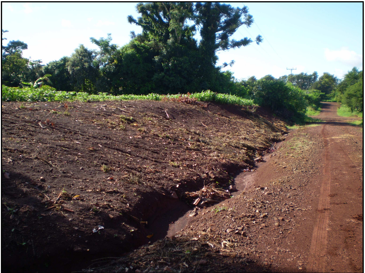
Figura 10 - Sulco na lateral de uma das ruas do distrito de São Roque, Marechal Cândido Paraná. Acervo Pessoal.
