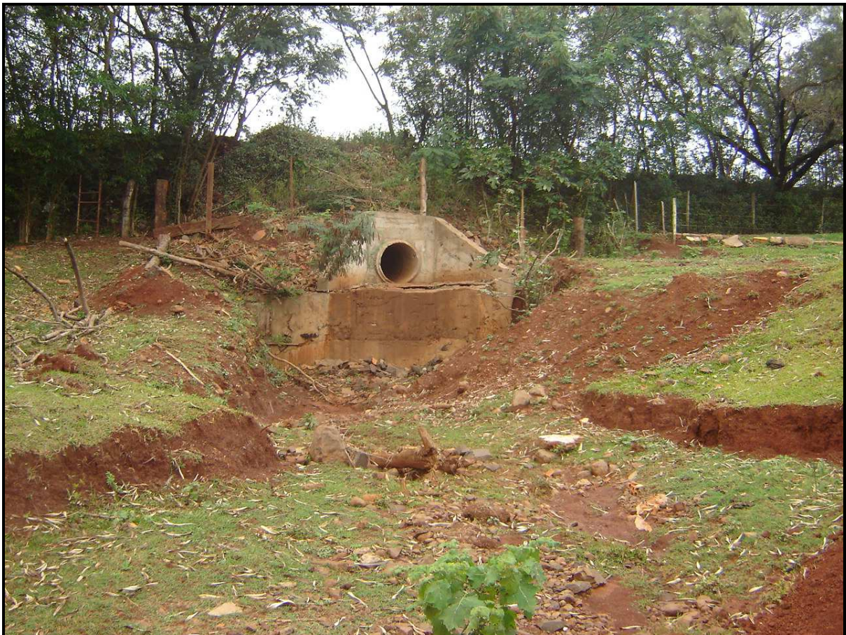
Figura 1 - Emissário de águas pluviais em área de cabeceira de drenagem do Córrego Guavirá. Marechal Cândido Rondon – Paraná. Fonte: Acervo Pessoal.
