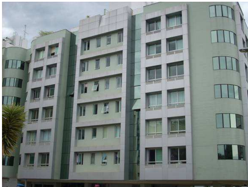
Figura 2.11 – Fachada com revestimento composto de pastilhas cerâmicas, chapas de alumínio e esquadrias de vidro
