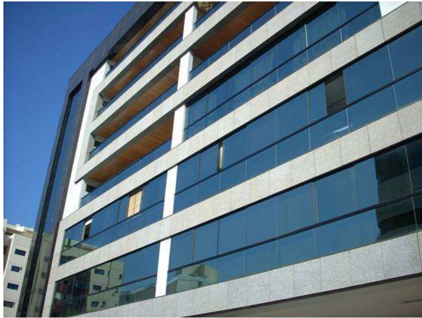
Figura 2.10 – Fachada com revestimento em granito e esquadria de vidro
