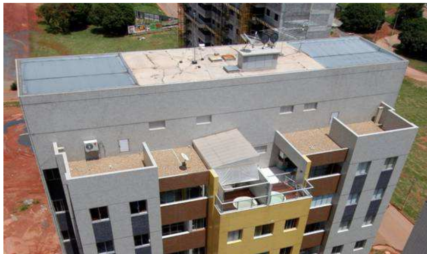
Figura 2.15 – Edificação com sistemas de impermeabilização
