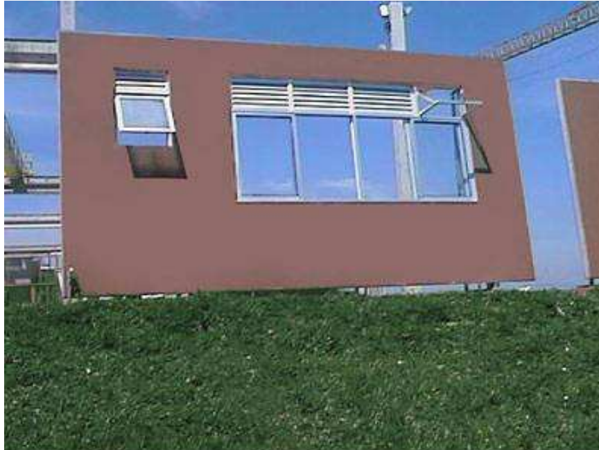
Figura 2.6 – Detalhe do painel pré-fabricado para fachada
