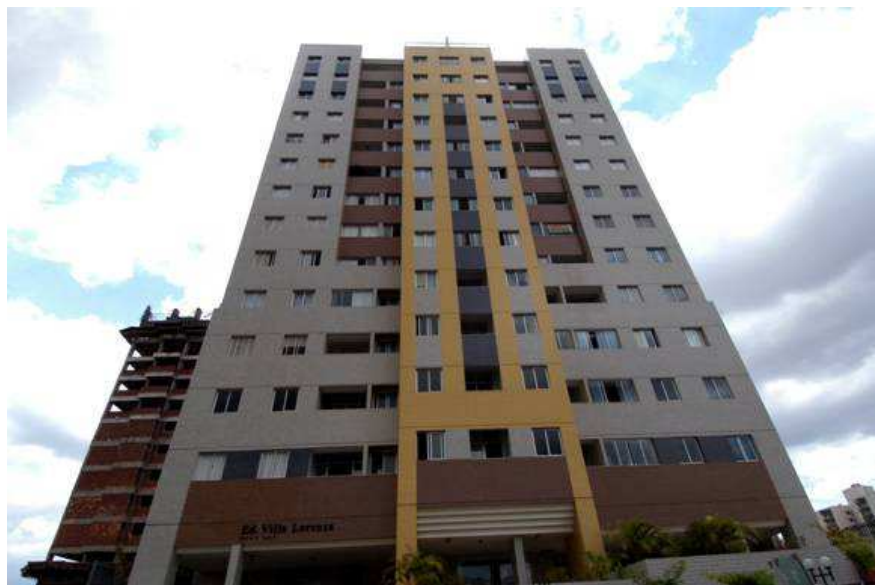
Figura 2.7 – Revestimento de fachada em pastilha cerâmica
