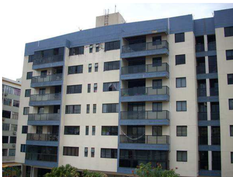
Figura 2.8 – Revestimento de fachada em pintura e pastilhas
