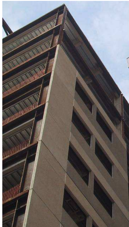
Figura 2.5 – Revestimento de fachada com painéis pré-fabricados
