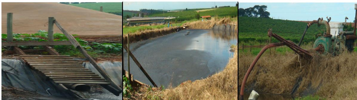
Figura 7. Efluente do biodigestor, reservatório e moto-bomba.
