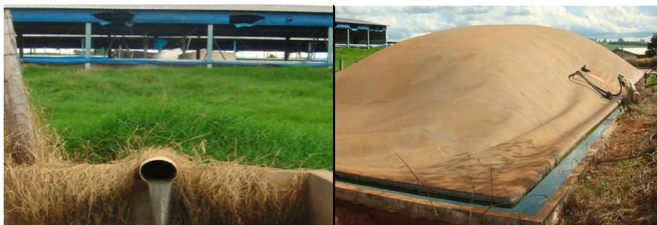
Figura 6. Afluyente da granja de suínos e biodigestor.
