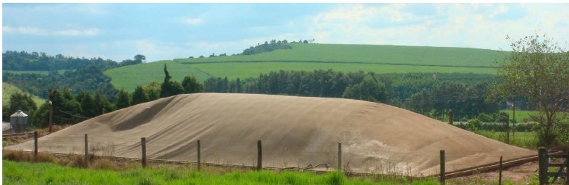
Figura 3. Biodigestor modelo tubular.
