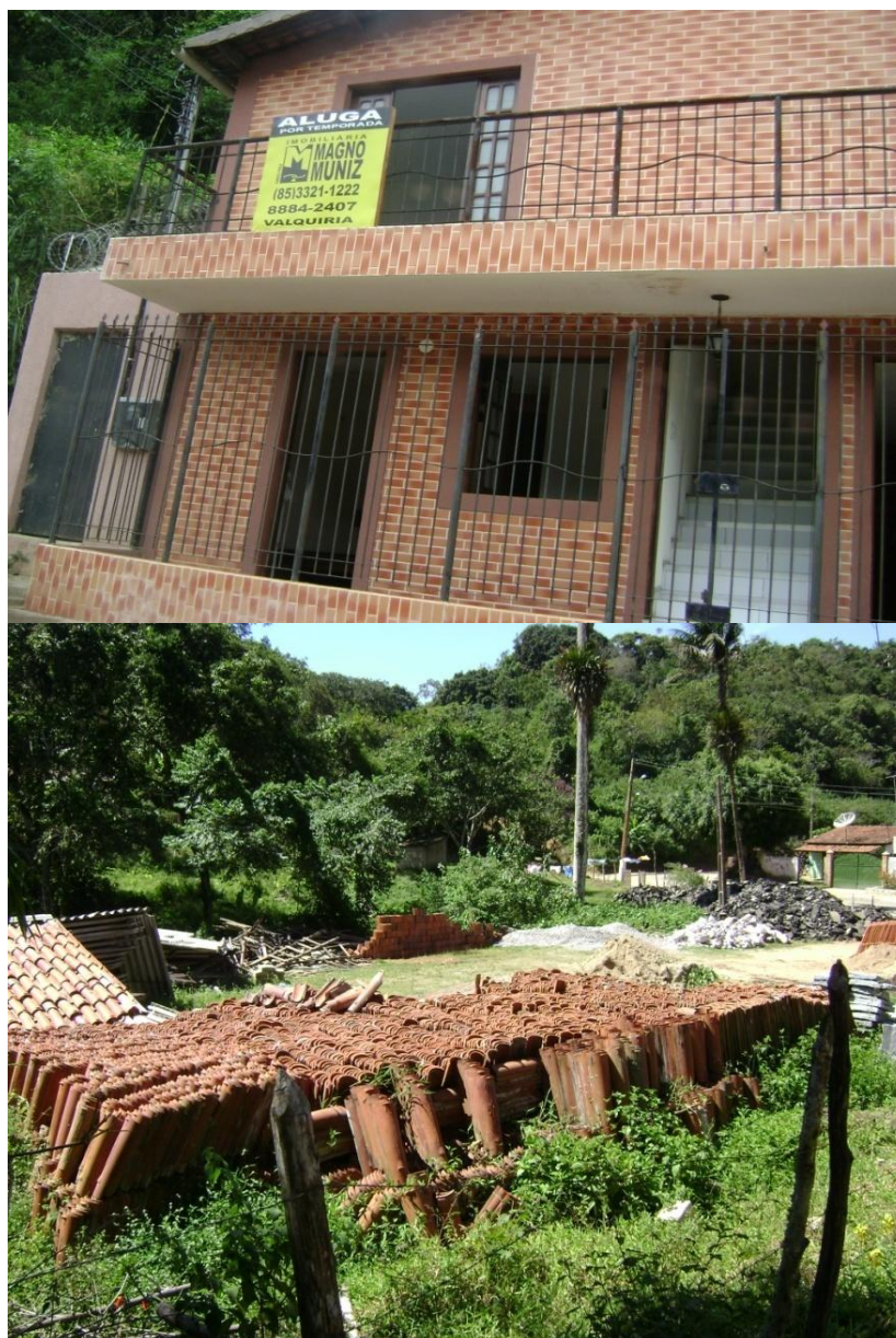
Figura 18 – Fotos de construções e imóveis em Guaramiranga FOTOS: Alexandre Sabino: 2007/2008
