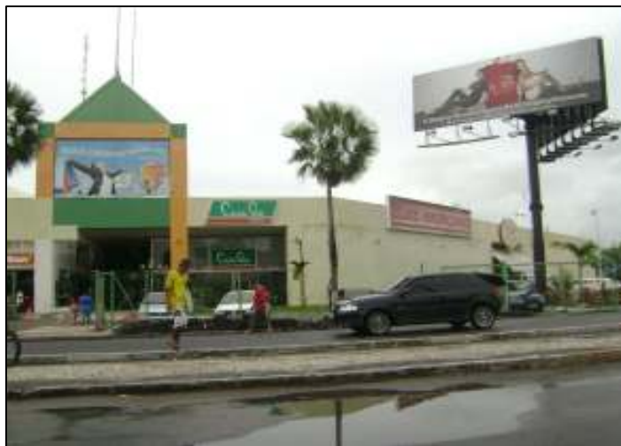
FIGURA 5 – Entrada do North Shopping Maracanaú , localizado no início da av. Central, no Centro de Maracanaú (av. Senador Carlos Jereissati). Foto: CARVALHO, Keane. 2009.
