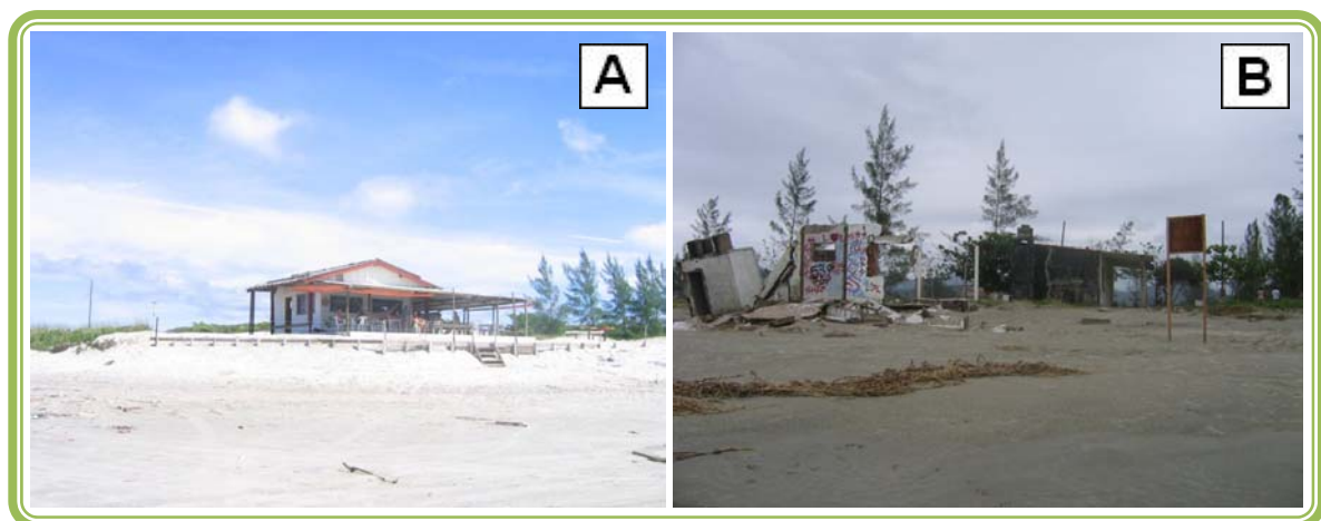
Figura 34. Alguns impactos decorrentes da ocupação desordenada. A – Quiosque sobre dunas em Ilha Comprida; B – Ruínas e casa construídas na região de pós-praia, em Ilha Comprida. (fotos: Ágata Romero)
