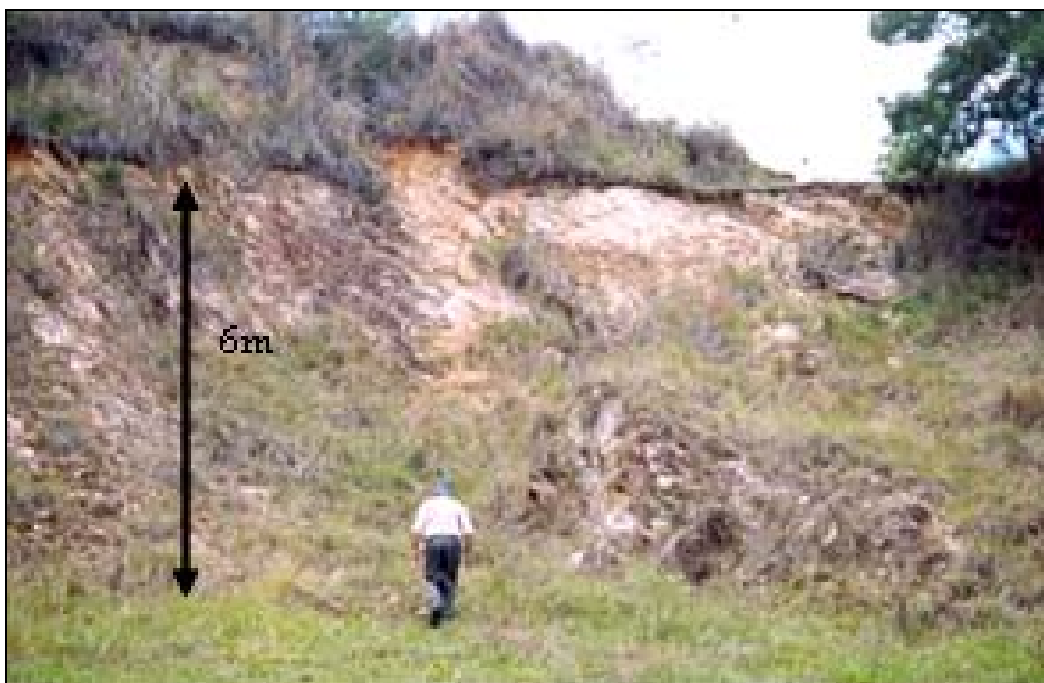
Figura 11 - Antiga frente de lavra de talco e amianto de Itapira (Fazenda Boa Esperança). Nota-se o corte em bancadas de aproximadamente 6 metros de altura.
