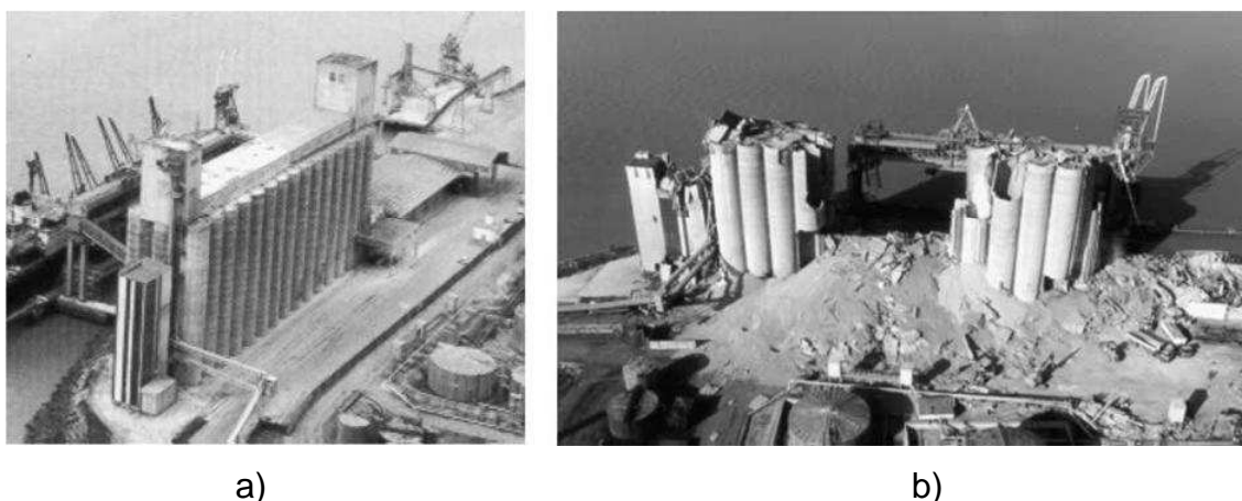
Figura 5 – Acidente em Blaye, França, Agosto de 1997 (11 mortes) (a) antes do acidente (b) depois do acidente Fonte: Mavrot et al (2003, p. 166)
