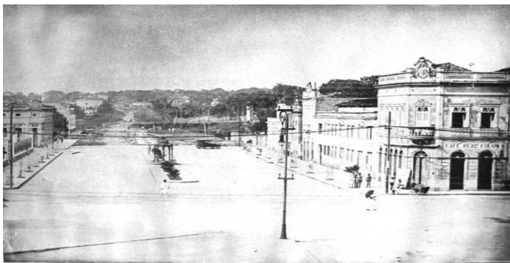
Avenida 13 de Maio — Trecho construído e trecho a concluir.
