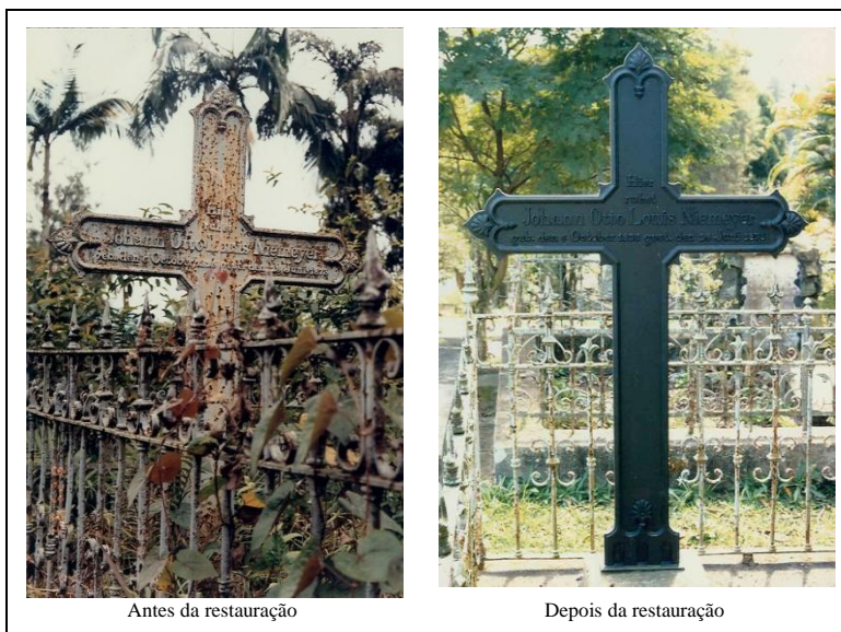
Figura n. 29 – Artefato metálico cruz/lápide tratado em 2000 com ácido fosfórico e camada de proteção à base de tinta para metal, fosca. (T394, fotos do ano da restauração, em 2000, do acervo do CPBC).
