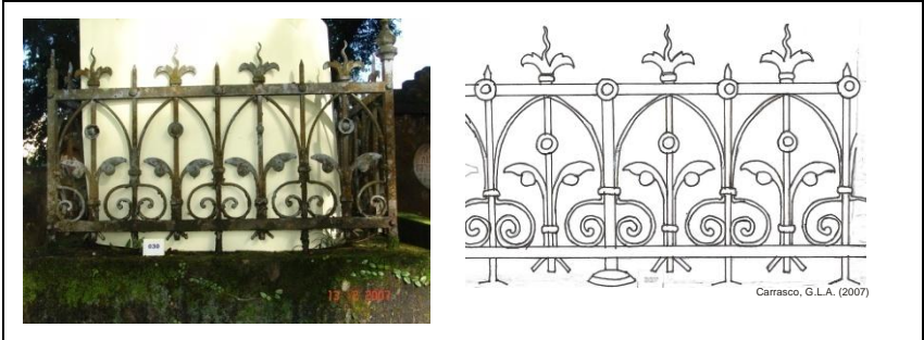
Figura n. 30 – T030 – Gradil confeccionado com técnica mista: ferro fundido, ferro forjado e folha recortada e martelada (Fotografia e desenho da autora, 2007)
