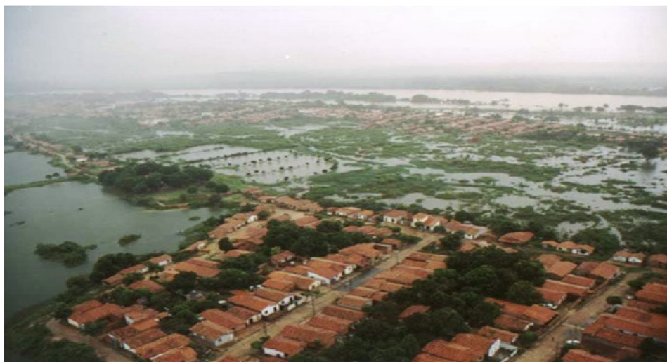
Figura 26: Vista panorâmica da zona Norte da cidade de Teresina coberta por água. Enchente de 2004. Fonte: Teresina, 2002.
