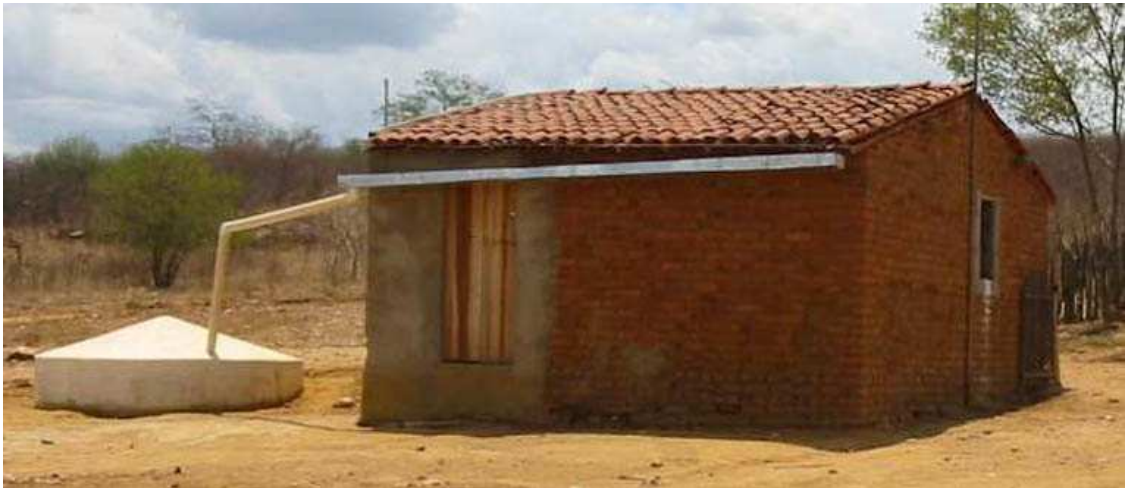
Figura 2.1.f: Residência no semi-árido brasileiro com sistema para aproveitamento das águas pluviais
