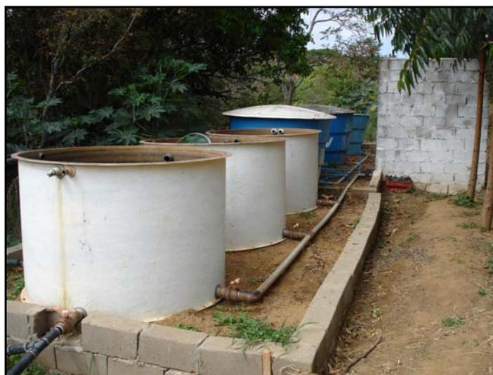
**Figura 4.11 - Reservatórios de água e efluente implantados na pesquisa**
