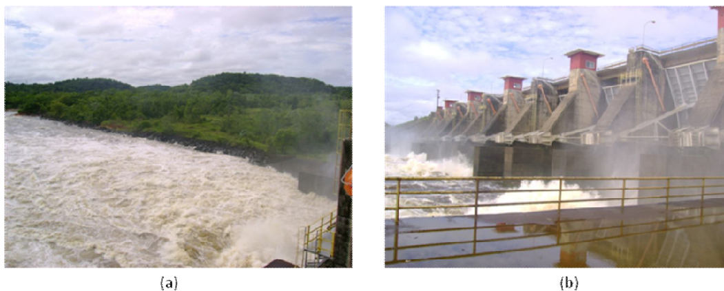
Figura 35: Imagens da água saindo dos vertedouros da UHECN no período chuvoso. a: vista de cima, b: vista lateral.
