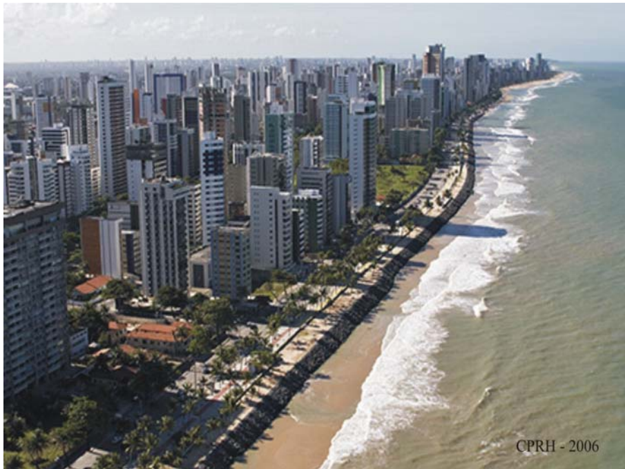
Foto 2 - Obra de contenção do tipo enrocamento aderente, ao sul da praia da Boa Viagem (CPRH, 2006).
