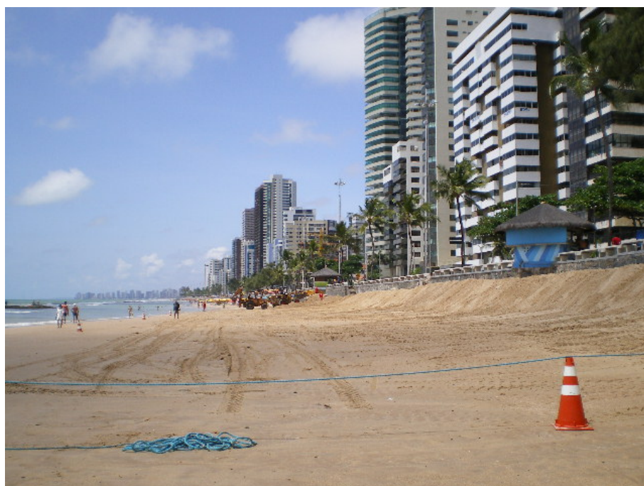
Foto 4 - Expansão do processo erosivo ao norte da Praça de Boa Viagem (Foto do autor, 2008).
