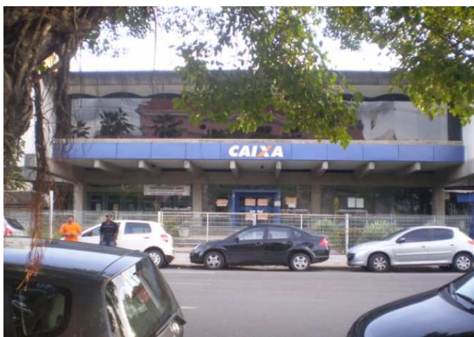
Foto 19 - Espaço em que funcionou o Teatro Marrocos Atual Agência da Caixa Econômica - 2008 Fonte: Acervo pessoal do Autor
