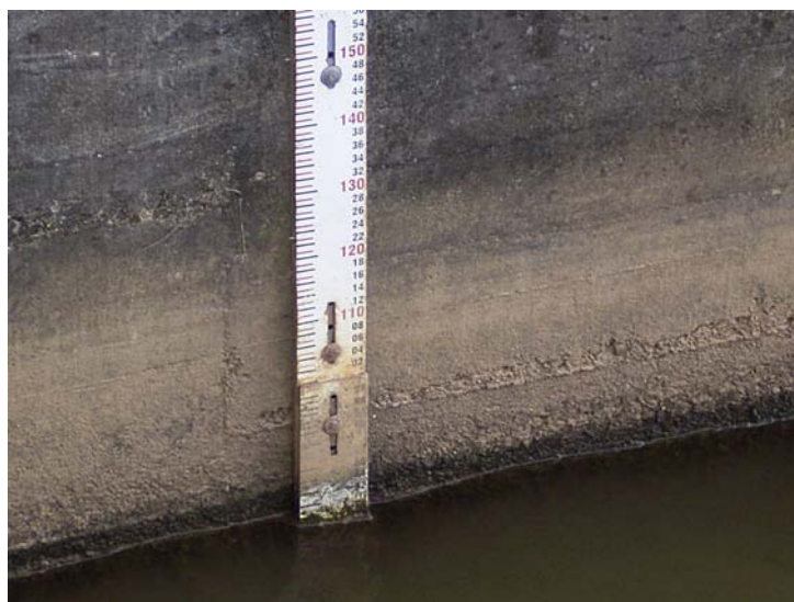
FOTO 10: RÉGUA LINMÉTRICA LOCALIZADA PRÓXIMA À CRISTA DO VERTEDOR DO LAGO DO PARQUE BARIGÜI.
