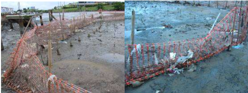
Figura 35 – Comprometimento da tela em função da grande quantidade de lixo.
