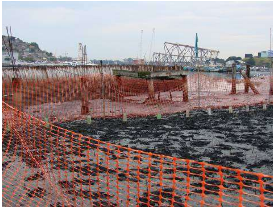
Figura 53 – Disposição da tela em forma retangular.
