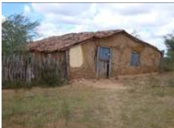
Figura 12- Casa de taipa na região do Cariri paraibano
