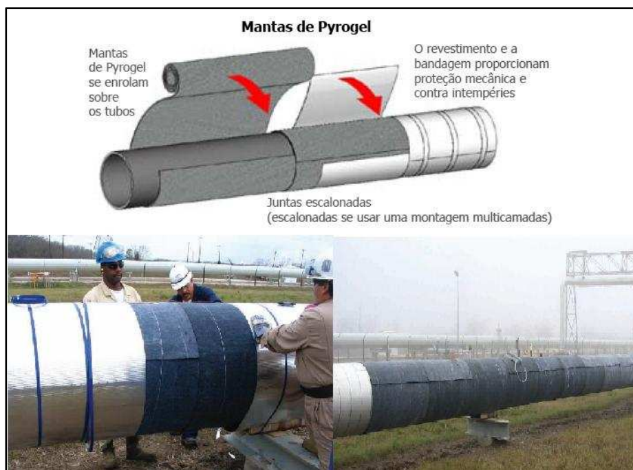
Figura 2.14 - instalação do Pyrogel (ASPEN AEROGELS, 2007).
