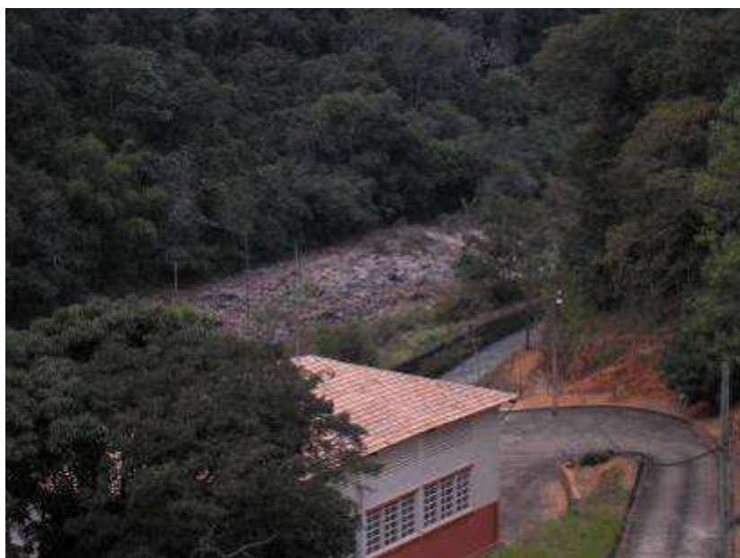
Foto 138 – Nesta imagem pode-se visualizar a Usina Hidrelétrica do Caboclo, onde o canal segue diretamente até outra usina mais a jusante denominada Usina Hidrelétrica do Salto.
