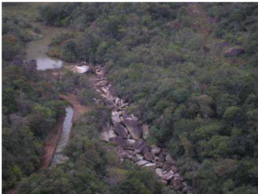
Foto 152 – Barragem para desvio de cerca de 50% da vazão do Rio Maynard, após a Usina do Caboclo e Salto, para alimentar a Usina Funil/Prazeres, situada na região conhecida como Funil.
