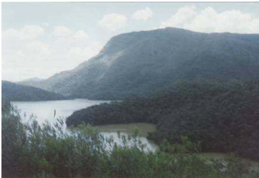
Foto 18 – Imagem mostrando o Lago “Tabuão” no Ribeirão da Cachoeira, formado desde o ano de 1958 para geração de energia no chamado Sistema Maynard constituído pelas Usinas do Caboclo, Salto e Funil/Prazeres.
