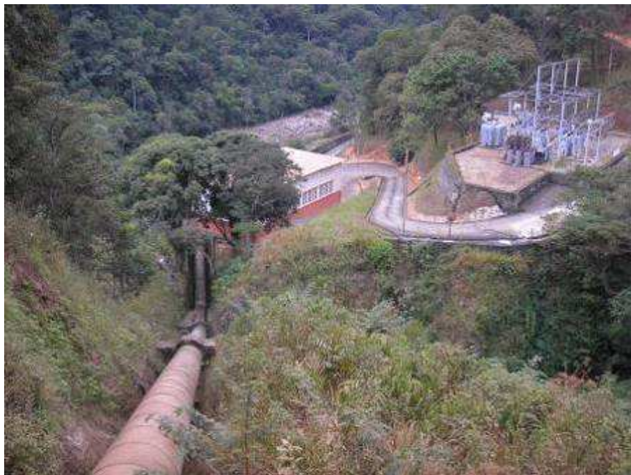
Foto 136 – Usina do Caboclo, que utiliza cerca de 80% da vazão do Rio Maynart para geração de energia, que tem como afluentes principais os Ribeirões da Cachoeira e Falcão.
