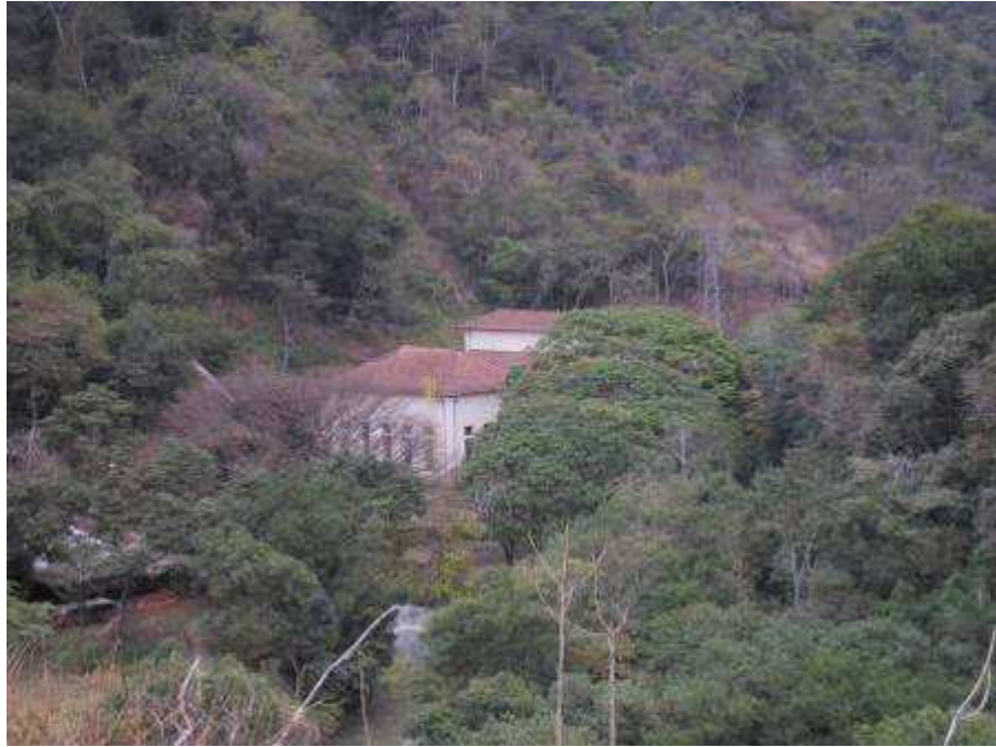
Foto 145 – Vista da Usina Hidrelétrica do Salto onde novamente o Rio Maynart se une e volta a correr no leito natural, a jusante da Usina do Salto,
