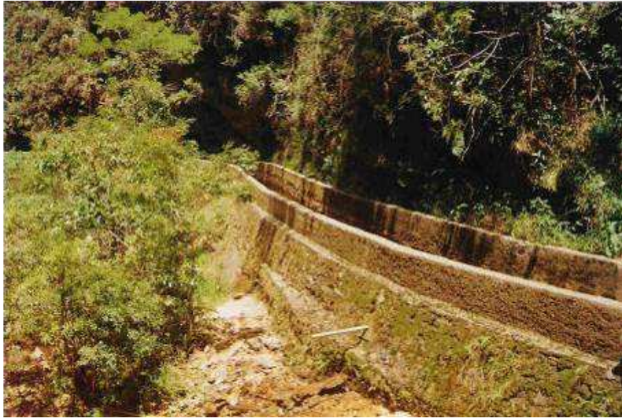
Foto 121 – Vista do canal de derivação construído na década de 50 para condução da água utilizada na geração de energia elétrica para a instalação da antiga Alcan Alumínio, atual Novelis S.A.
