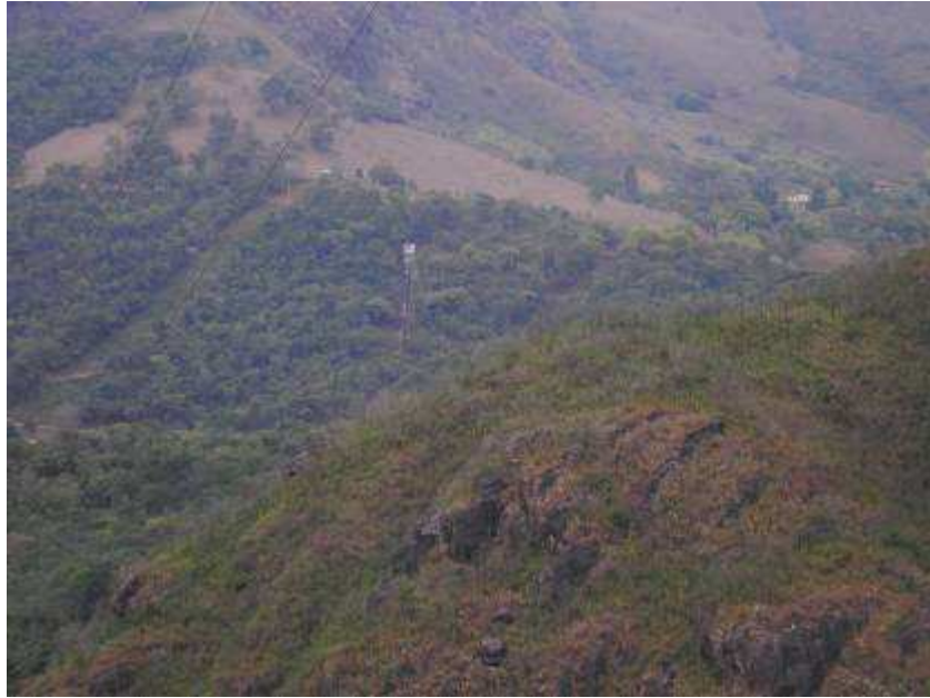
Foto 153 – Vista parcial da tomada de água da Usina do Salto, tomada da estrada de acesso à Usina Funil/Prazeres.
