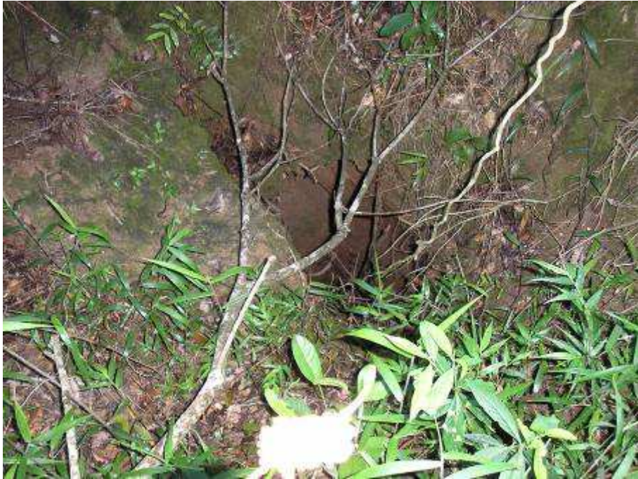
Foto 87 – Vista de sumidouro próximo à Estrada Real no trecho Ouro Preto-Ouro Branco e à Ponte sobre o Ribeirão Falcão.
