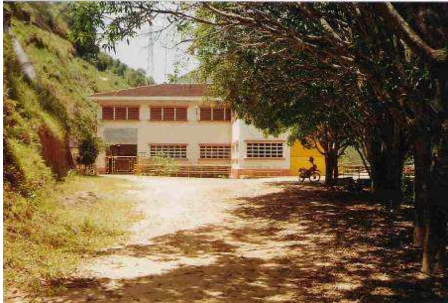
Foto 111 – Vista da Usina Funil/Prazeres, situada no extremo leste da Bacia do Rio Maynard, que utiliza grande parte do potencial hídrico desta região.
