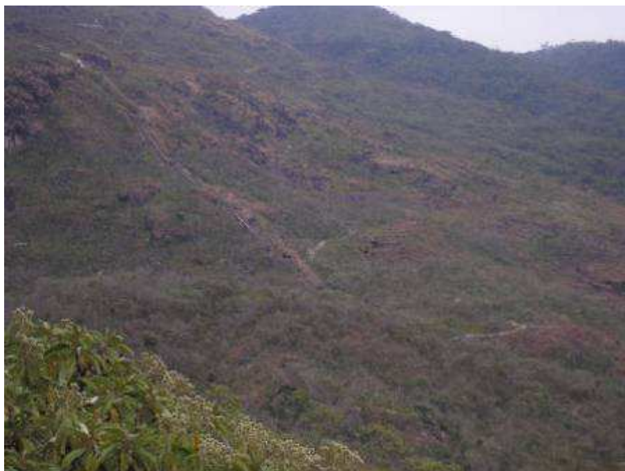
Foto 157 – Conduto forçado da Usina Funil/Prazeres: para girar as turbinas da Usina, a tomada d'água atinge uma diferença de nível aproximada de 100m, uma quantidade considerável de energia potencial hídrica a ser transformada em energia elétrica.
