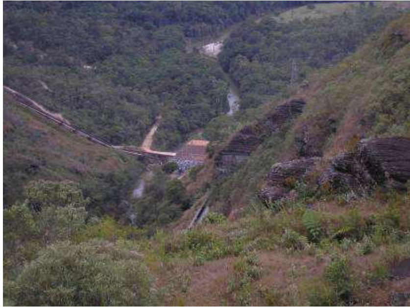
Foto 155 – As duas tomadas d'água da Usina Funil/Prazeres, uma no Rio Maynard e outra no Córrego dos Prazeres, em região no extremo da área de pesquisa.
