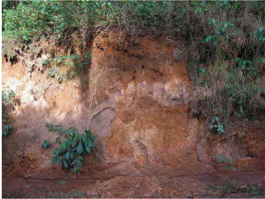
Foto 73 – Aspecto do solo no início do período chuvoso mostrando que ainda não foi possível a inteira permeabilização do solo deste local.
