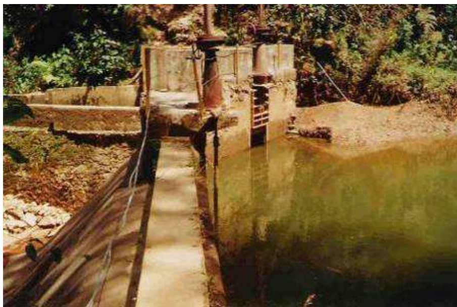
Foto 107 – Uma das três pequenas barragens na bacia pesquisada do Rio Maynard, utilizadas para o desvio do curso d'água até as usinas do Sistema Maynard de Energia.
