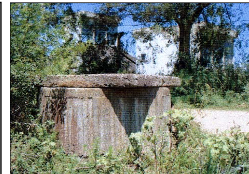
Poço de Visita localizado na vala da Av. Irineu C. de Braga. Em 2º plano está a ETE de Canoas. Data: 20/02/04
