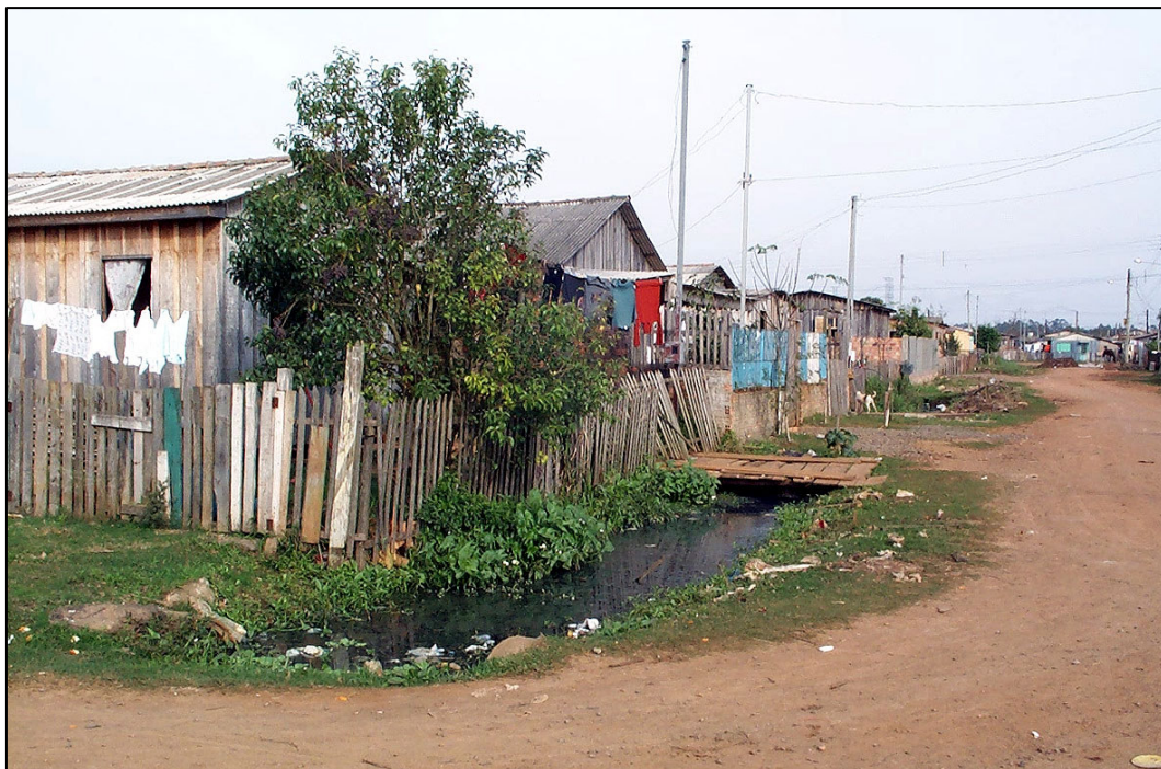
Foto 17: Rua da Vila Getúlio Vargas, no Bairro Mathias Velho com esgoto sanitário escorrendo a céu aberto em frente às moradias. Foto: Prefeitura Municipal de Canoas. Data: 01/07/2003.
