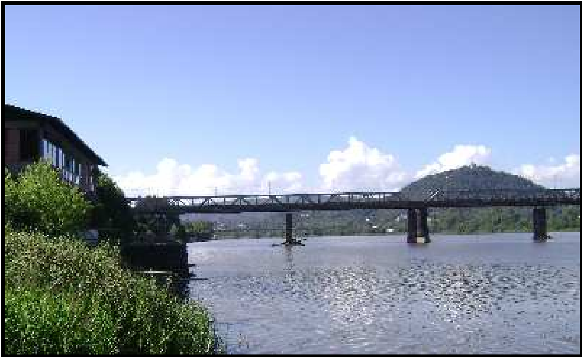
Figura 9 - Ponte Machado da Costa, vista da rampa de acesso ao Rio Iguaçu em Porto União – SC (2009)
