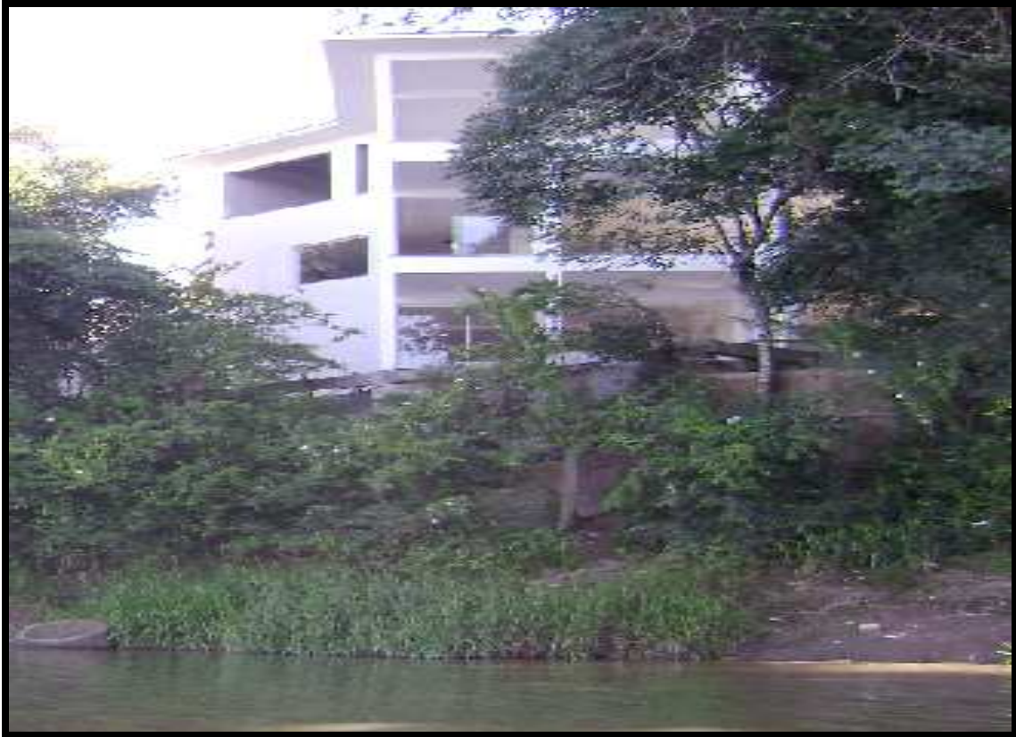
Figura 18 - Edificação em construção às margens do Rio Iguaçu, na área urbana de Porto União – SC (2009)
