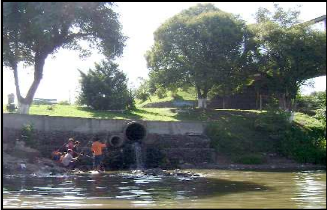
Figura 1 1- Tubulação ao lado da Ponte Machado da Costa, em Porto União – SC (2009)
