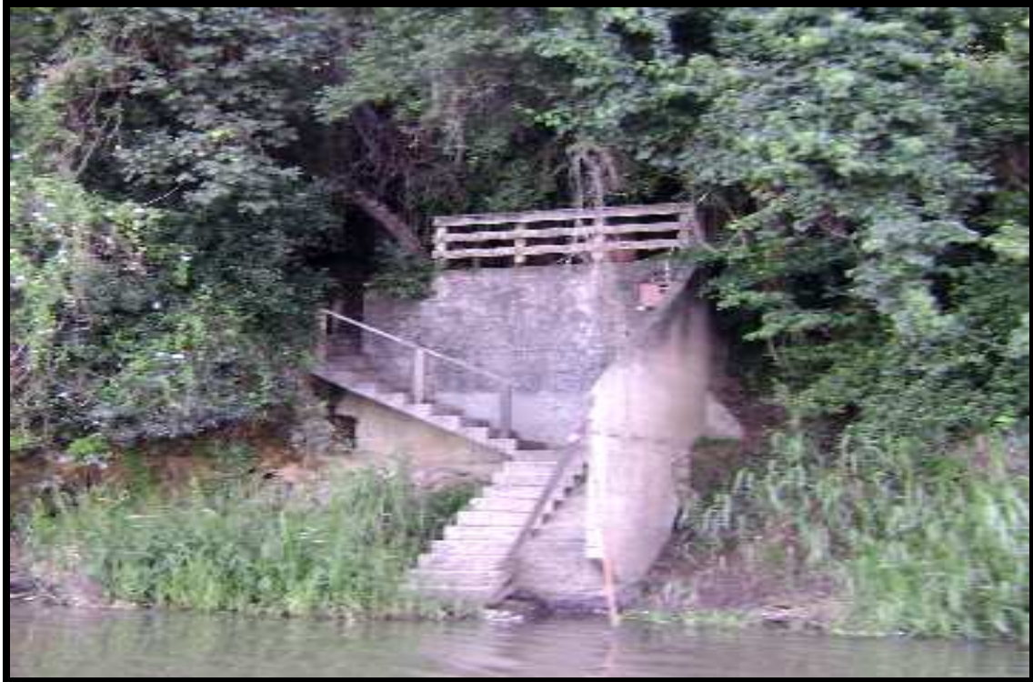
Figura 23 - Acesso particular ao Rio Iguaçu, Porto União - SC (2009)
