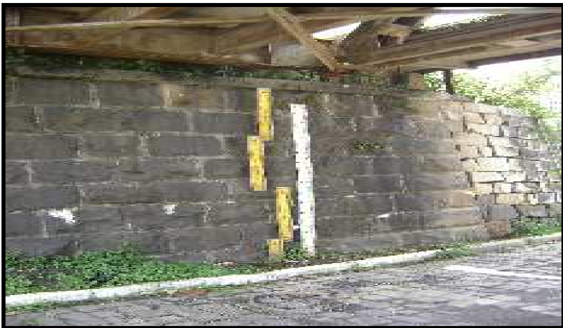
Figura 4 - Réguas para medir enchentes, sob a Ponte Machado da Costa em Porto União (2009)
