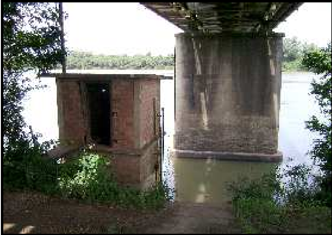
Figura 2 - Posto fluviométrico sob a Ponte Machado da Costa em Porto União – SC (2009)
