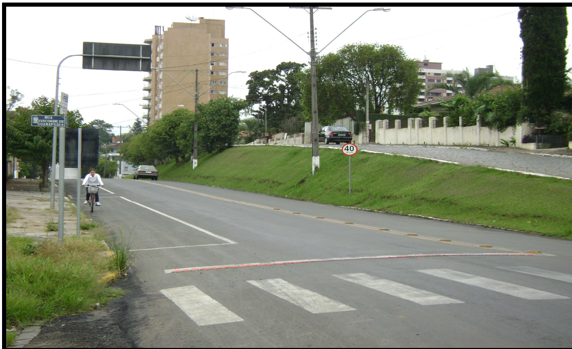
Figura 46 - Rua Coronel Amazonas, na APP às margens do Rio Iguçu, em Porto União – SC (2009)
